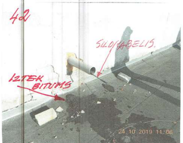
JUNTA LIETUSŪDEŅU NOTEKCAURULES SATEK BITUMS.
