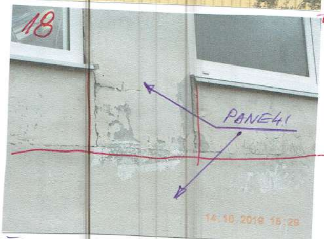
ĀRĒJĀ SIENĀS IZBŪVĒTAS KĪEG. MŪRA KONSTRUKCIJĀ STARP KOLONĀM UN UZKARINĀMĀ, PANEĻU KONSTRUKCIJĀ - PAŠNEŠOŠĀS SIENĀS.
