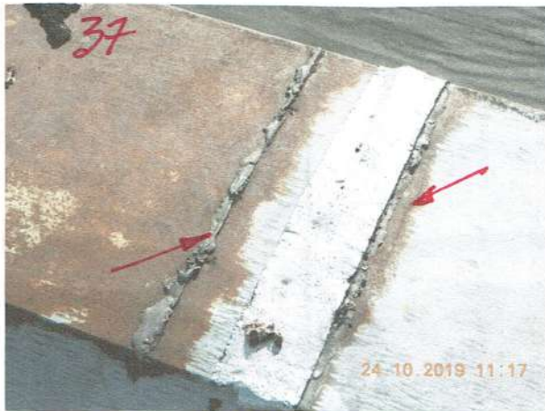
JUNTA PARAPETA IESEGUMA KOROZIJA UN PIESLĒGUMI JUNTAM.
