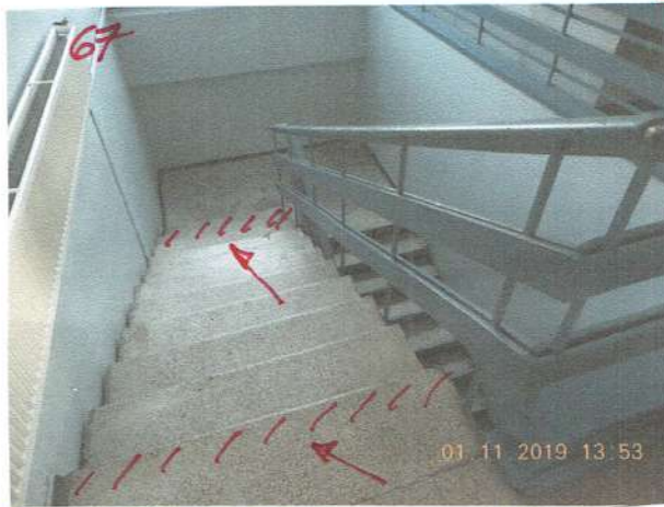
D2. BET. KĀPNŪ KONSTRUKCIJAS BEZ BŪTISKIEM DEFECTIEM. NAV IEZĪMĒTI AIRĒIE UN PĒDĒJIE PĀNĀPIENI.
