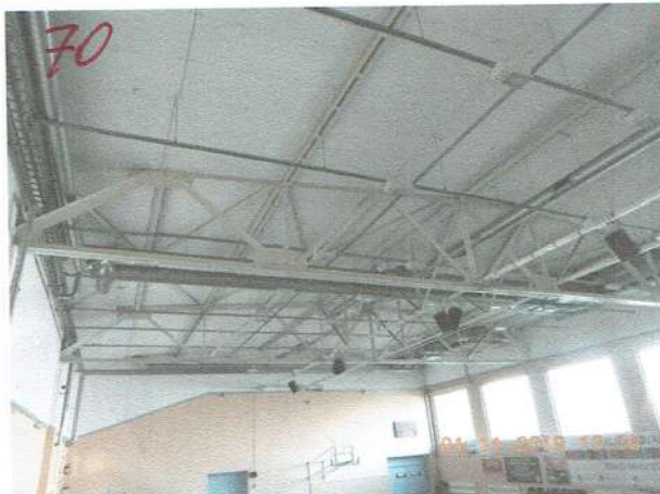
FUNTA METĀLA NESOŠĀS KROVS- TRUCIJAS UN TO SAVIENOJUMU IEMZGLI APM. TĒHN. STĀVOKLĒ,
