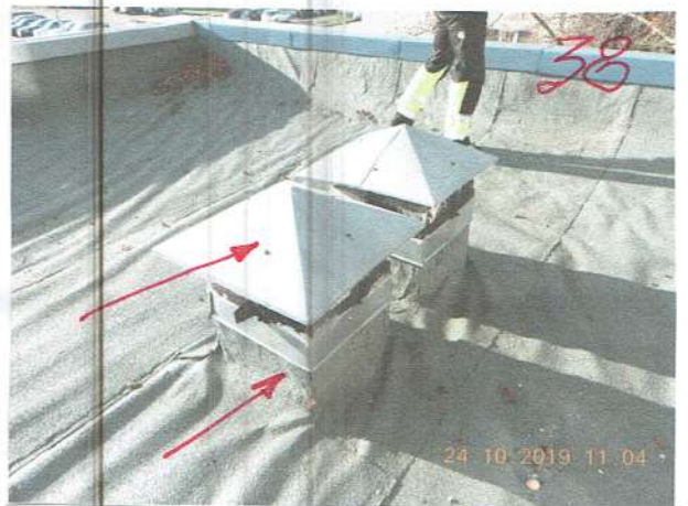
JUNTA PARAPETA IESEGUMA KOROZIJA UN PIESLĒGUMI JUNTAM.
