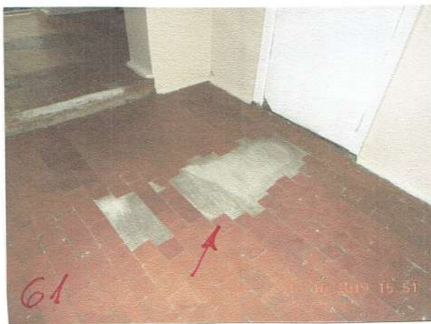
DURUJU AILES DEFORMĀCIJAS SVARU ZĀLES DUSĀF.
