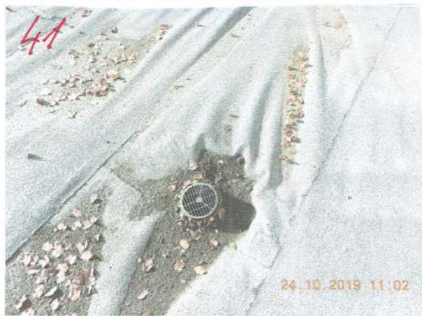
JUNTA LIETUSŪDEŅU NOTEKCAURULES SATEK BITUMS.
