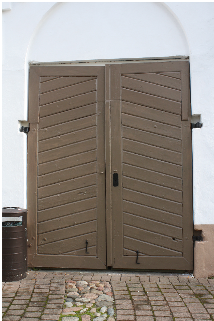
Bazniicas_lauk_4_88010120192001_durvis4 Vēsturiskas kapličas durvis torņa labajā pusē.
