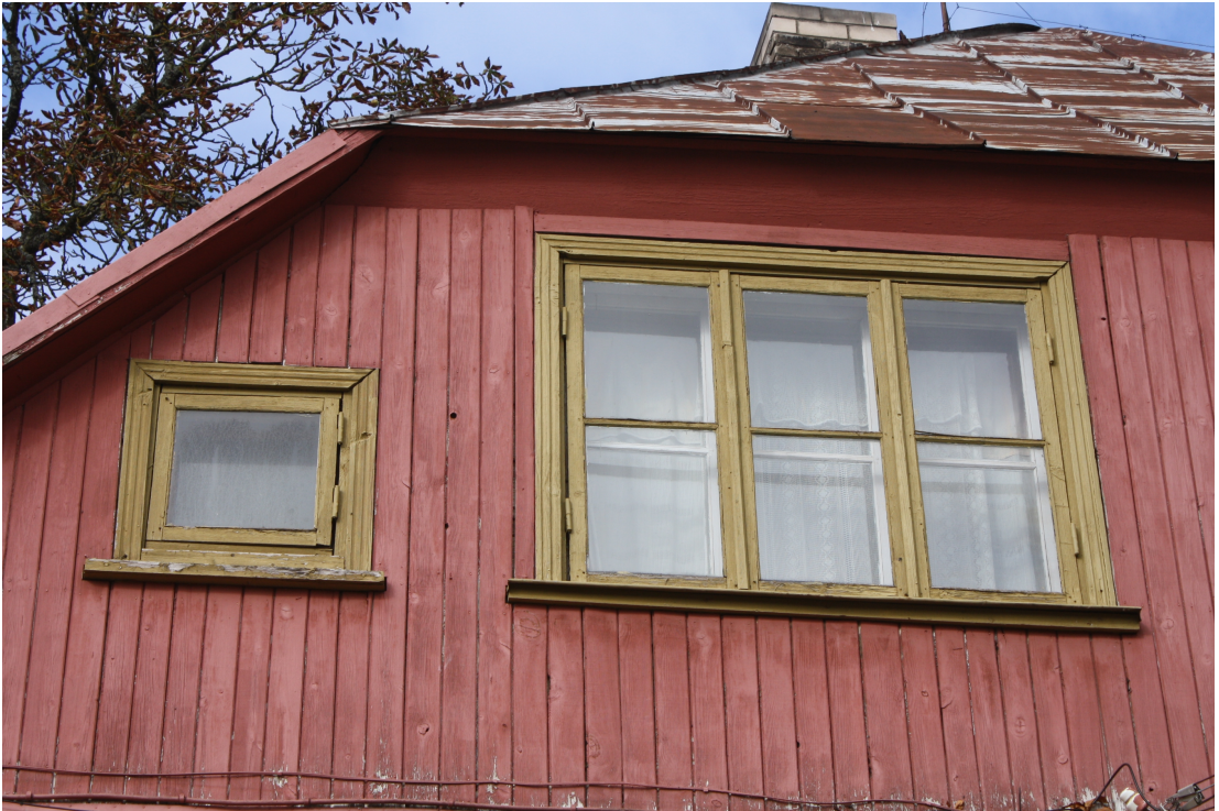
Dzirnavu_1_88010120207001_fragments2 Vēsturiski logi ēkas dienvidaustrumu fasādes zelmīnī.
