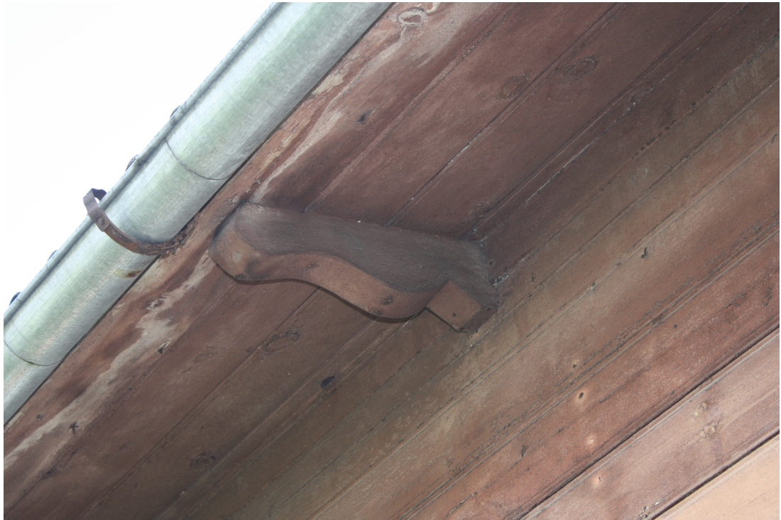
Ezera_2_88010120003001_detala1 Skats uz ieejas lieveņa jumta konstrukcijas oriģinālo spāri.
