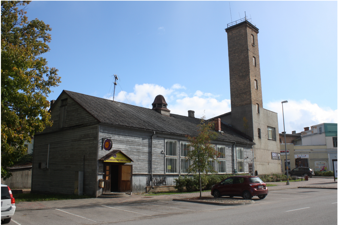
Ezeru_lauk_1_88010120198002_fasade1 Skats uz ēku no ziemeļrietumiem. Fasāde pārbūvēta 20.gs.2.pusē (likvidēts mezonīns, izmainīts ailojums).
