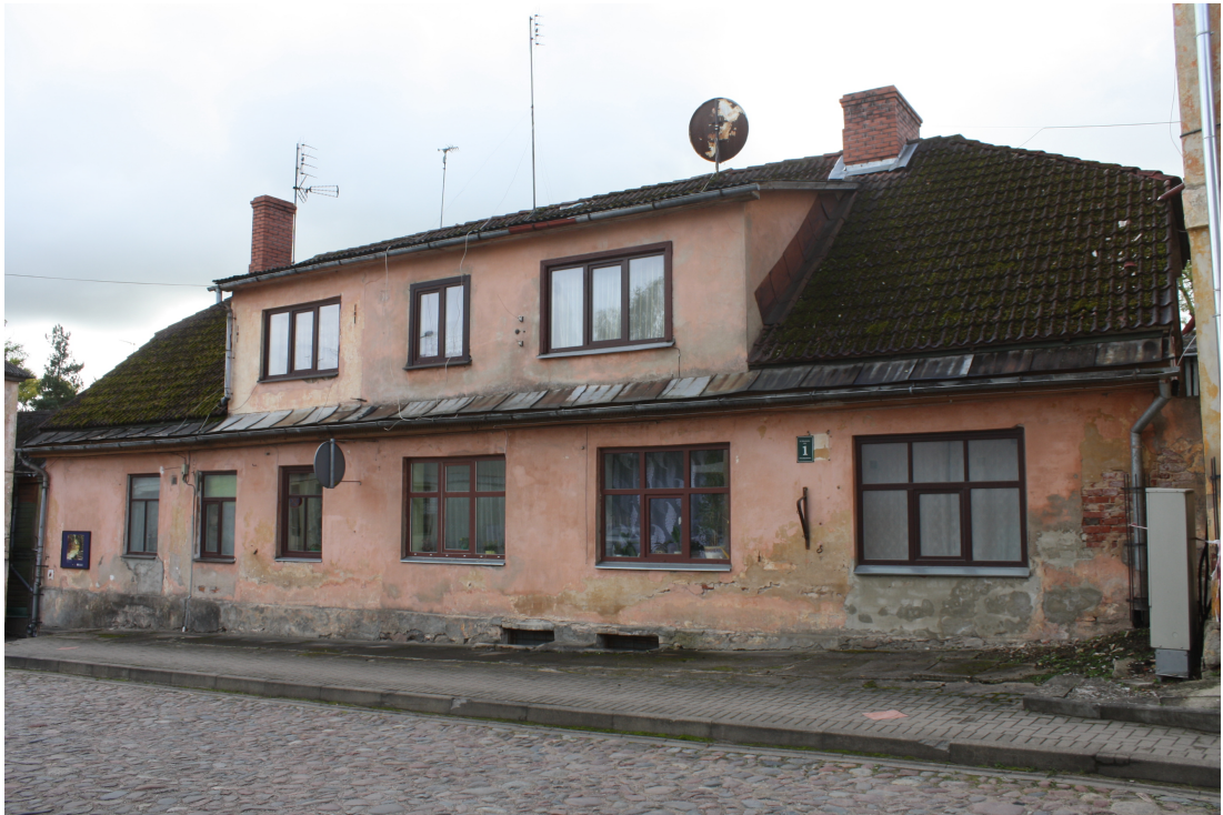
Kaarlja_Miilenbaha_1_88010120212001_fasade1 Skats uz ēku no ziemeļaustrumiem. Kārļa Miilenbaha ielas fasāde. Jumta izbūve izveidota 20.gs.2.pusē.
