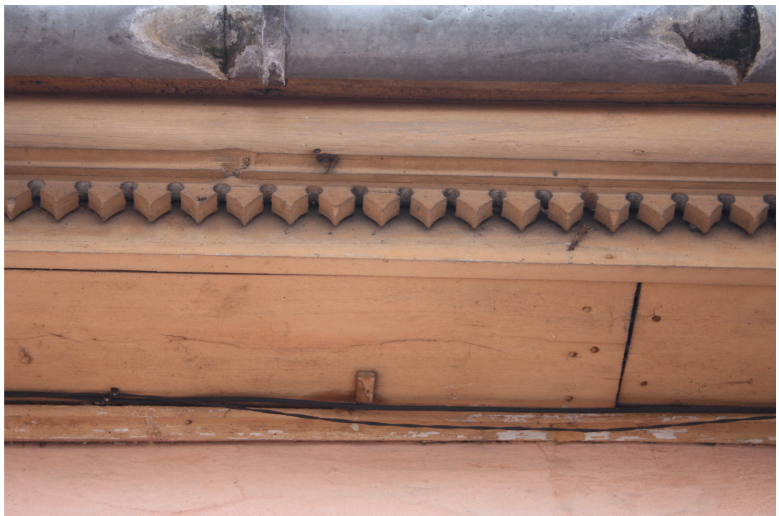
Kaarlja_Miilenbaha_1_88010120212001_dzega1 Vēsturiska dēļu dzega.
