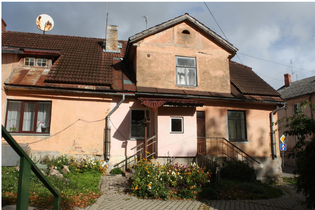
Kaarlja_Miilenbaha_1_88010120212001_fasade5 Skats uz pagalma fasādes austrumu galu. Piebūve - 20.gs.2.puse.
