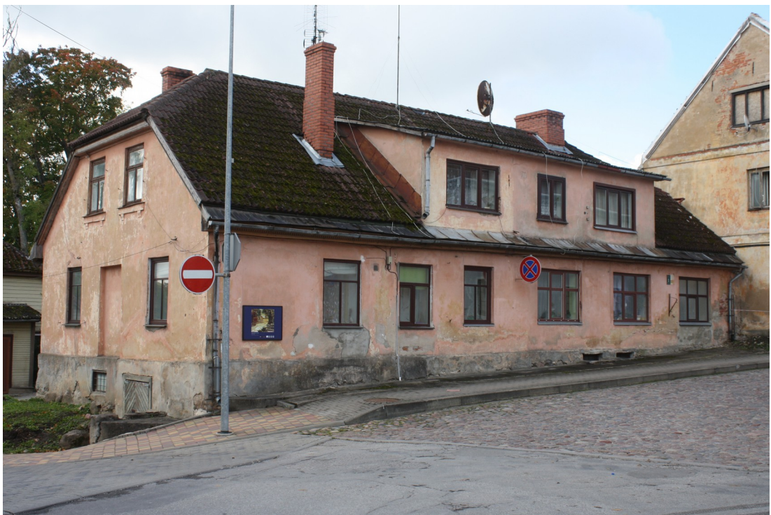
Kaarlja_Miilenbaha_1_88010120212001_fasade2 Skats uz ēku no austrumiem. Jumta izbūve izveidota 20.gs.2.pusē.
