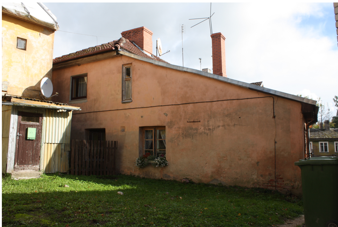
Kaarlja_Miilenbaha_1_88010120212001_fasade6 Skats uz ēku no rietumiem.
