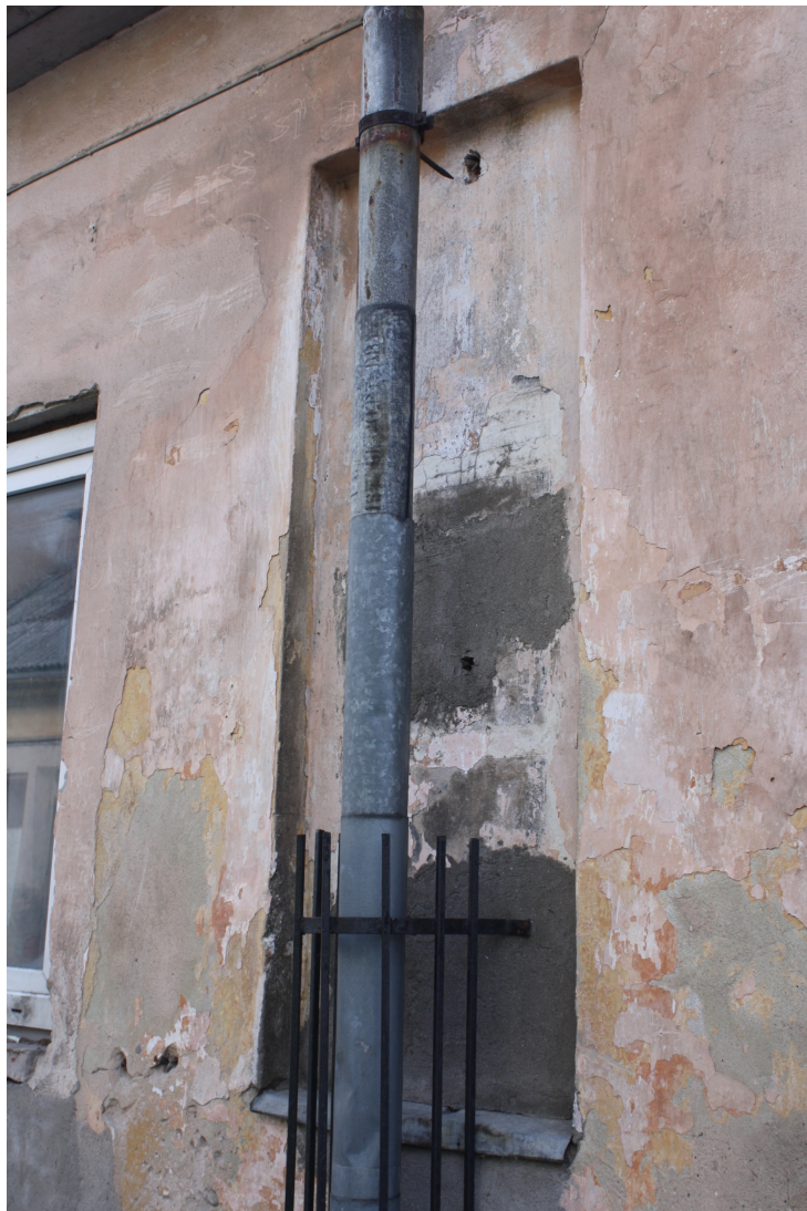
Kaarlja_Miilenbaha_3_88010130084 001_fragments2 Sākotnējais (19.gs.b., pēc 1886.g.) "aklais" logs ar daļēji saglabājušos oriģinālo krāsojumu.
