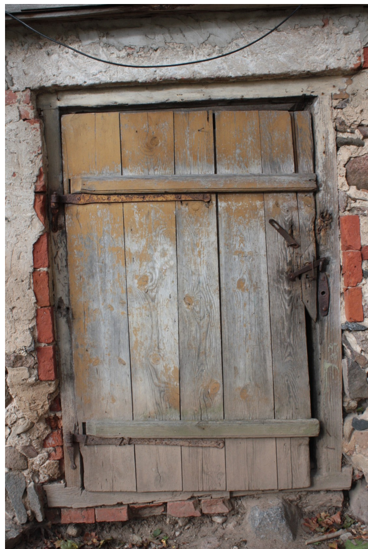
Kaarlja_Miilenbaha_5_88010130085001_durvis1 Vēsturiskas durvis ar oriģinālo aprīkojumu.
