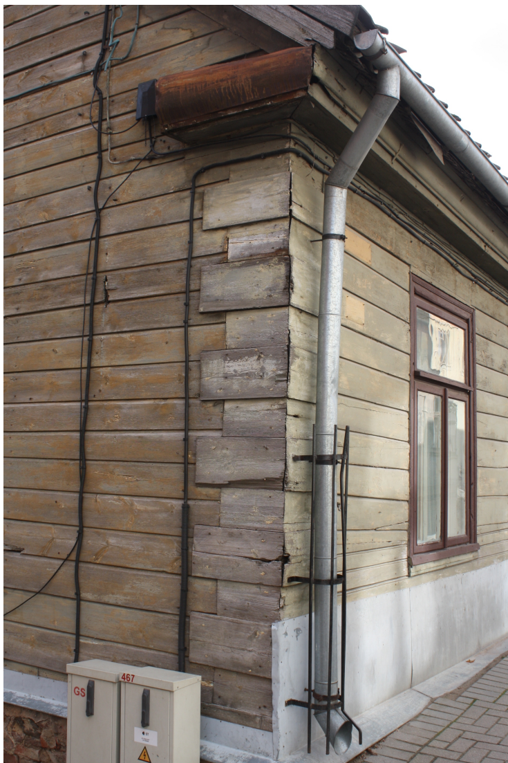
Kaarlja_Miilenbaha_5_88010130085001_fragments1 Vēsturiska (19.gs.1.p.) dēļu apdare un stūra rusti. Sekundārs skārda apšuvums fasādes lejasdaļā.
