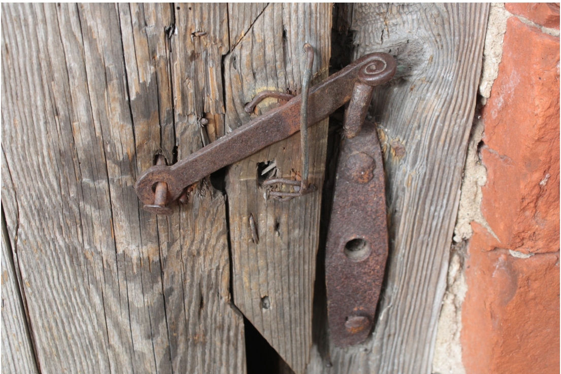
Kaarlja_Miilenbaha_5_88010130085001_durvis3 Vēsturisks durvju fiksators aizvērtā stāvoklī.
