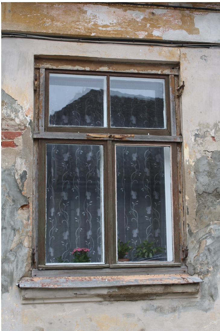
Kaarlja_Miilenbaha_6_8_88010130102001_logs1 Pārveidota sākotnēja loga aploda ar oriģinālajiem slēgu viru kāšiem. Loga vērtnes vēsturiskas.
