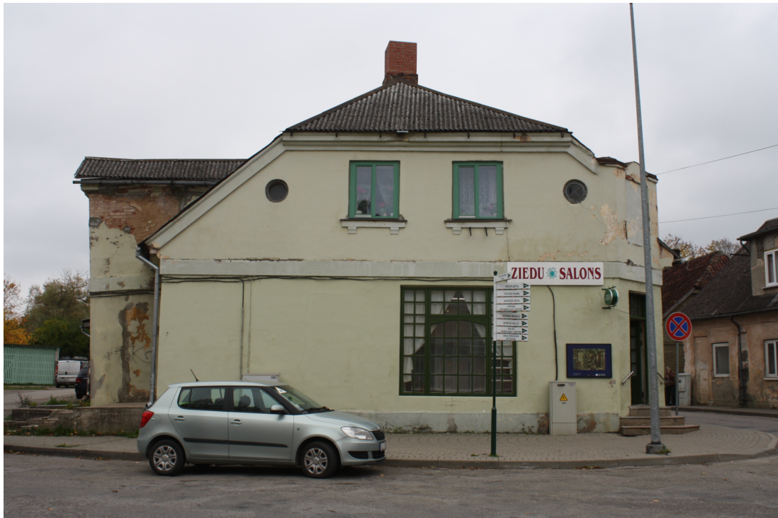
Kaarlja_Miilenbaha_6_8_88010130102001_fasade4 Skats uz ēku no rietumiem.
