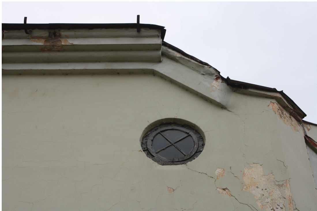
Kaarlja_Miilenbaha_6_8_88010130102001_fragments3 Vēsturisks lodziņš ēkas zelmīnī.
