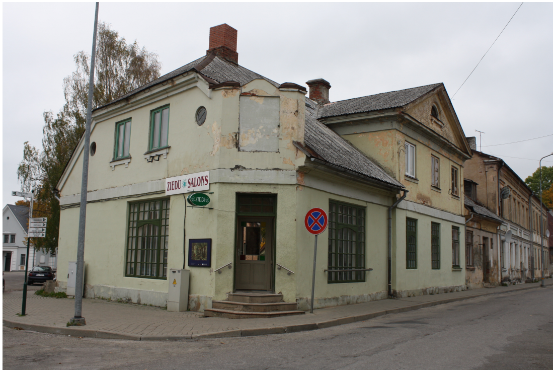
Kaarlja_Miilenbaha_6_8_88010130102001_fasade1 Skats uz ēku no dienvidrietumiem. Stūra nošļaupums un parapets izveidots 20.gs.30.gados.
