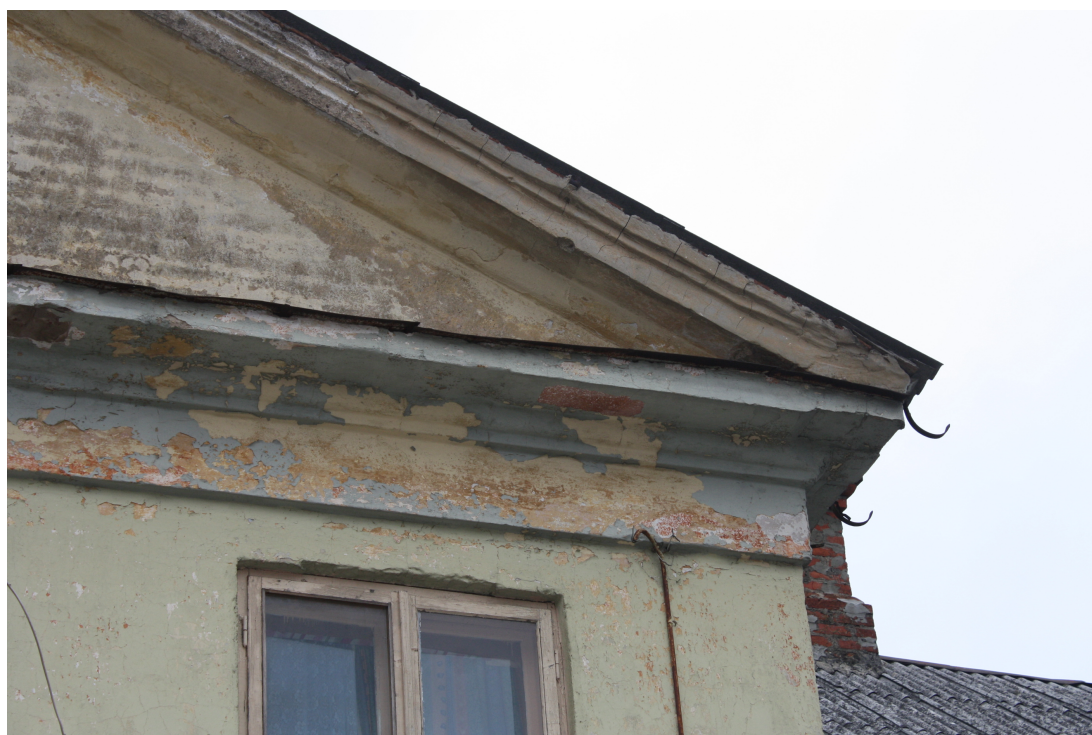
Kaarlja_Miilenbaha_6_8_88010130102001_fragments1 Sākotnējās (19.gs.2.cet.) dzegas mezonīna frontonā.
