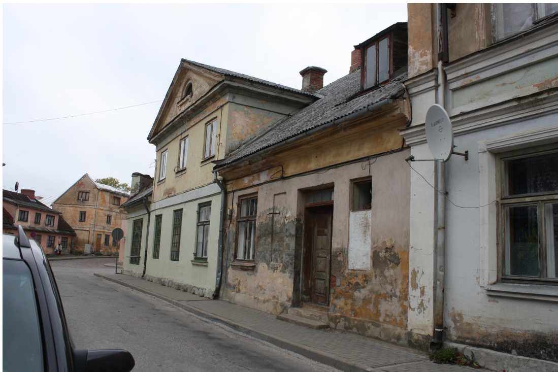
Kaarlja_Miilenbaha_6_8_88010130102001_fasade3 Skats uz ēku no dienvidaustrumiem. Jumta izbūve – 20.gs.2.puse.
