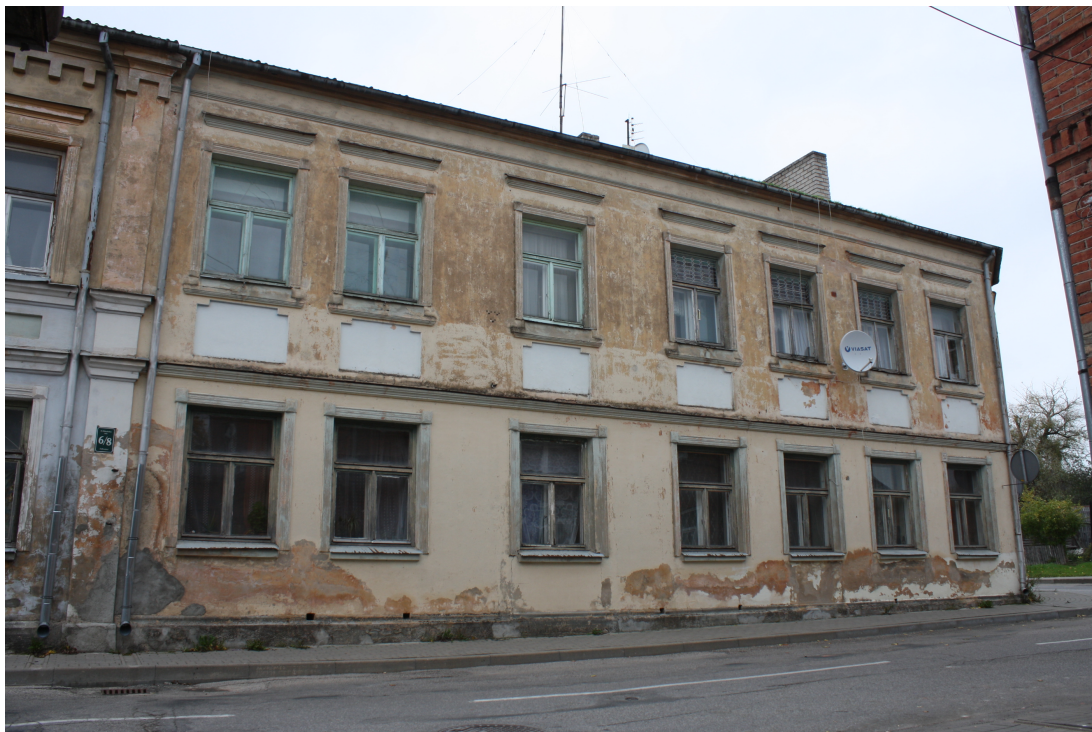
Kaarlja_Miilenbaha_6_8_88010130102002_fasade3 Ēkas jaunākā daļa, kas uzcelta līdz 1914.gadam.
