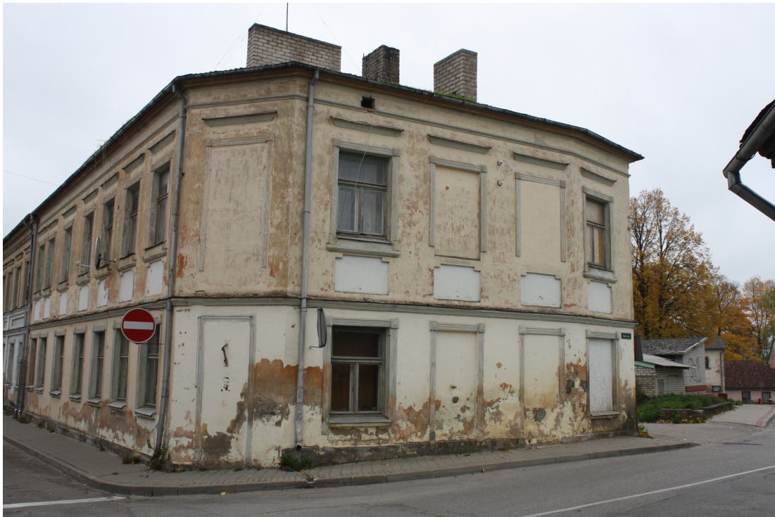
Kaarlja_Miilenbaha_6_8_88010130102002_fasade5 Ēkas fasāde pret Rožu ielu.
