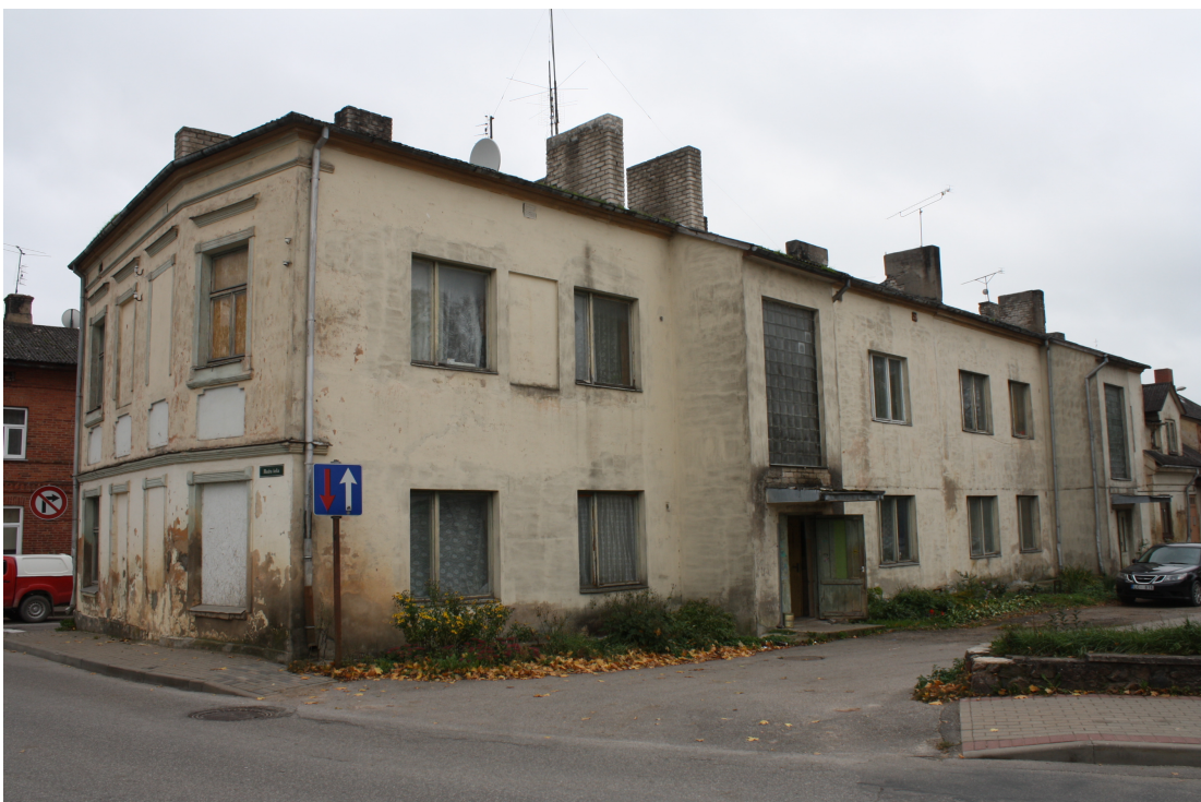
Kaarlja_Miilenbaha_6_8_88010130102002_fasade6 Skats uz ēku no ziemeļaustrumiem. Redzama 20.gs.50.,60.gados pilnībā pārbūvētā fasāde un 2 piebūves.
