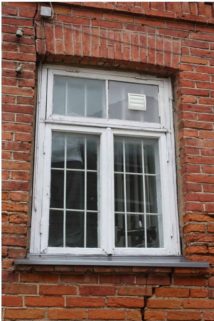
Kaarlja_Miilenbaha_7_88010130115001_logs1 Sākotnējais (19.gs.4.cet.) logs ar oriģinālo aprīkojumu ielas fasādē.
