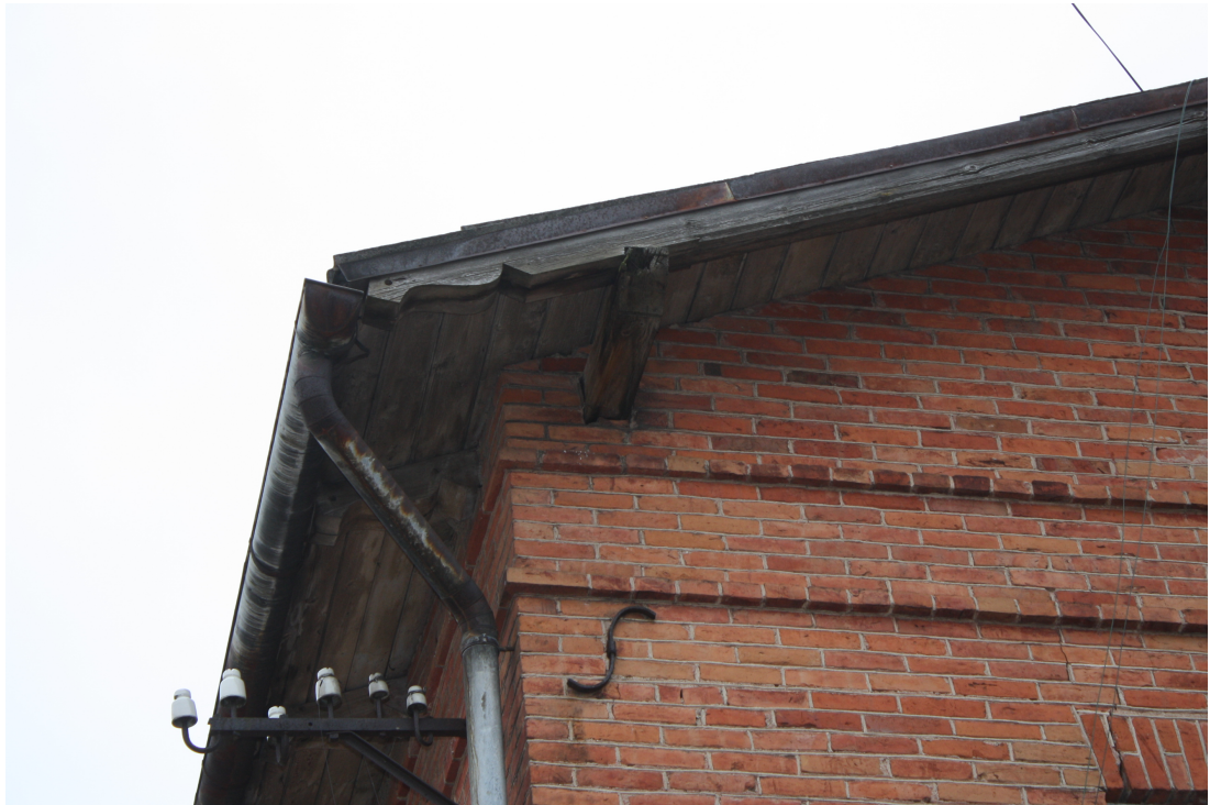
Kaarlja_Miilenbaha_7_88010130115001_fragments1 Ēkas stūra fragments ar sākotnējām (19.gs.4.cet.) ķieģeļu starpdzegām, spāri un metāla enkuru.
