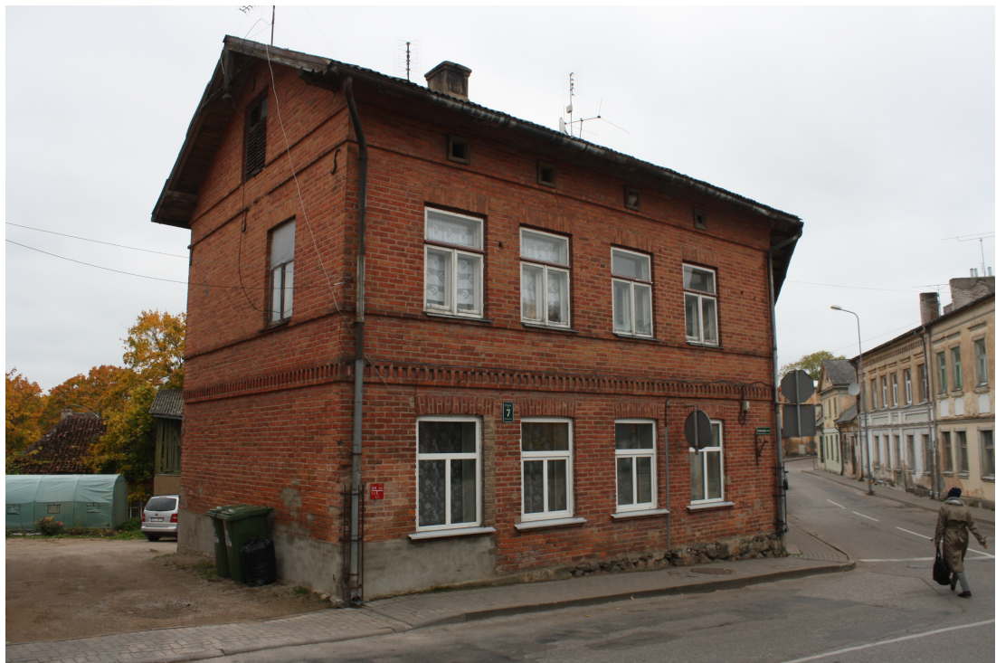
Kaarlja_Miilenbaha_7_88010130115001_fasade4 Skats uz ēku no austrumiem.
