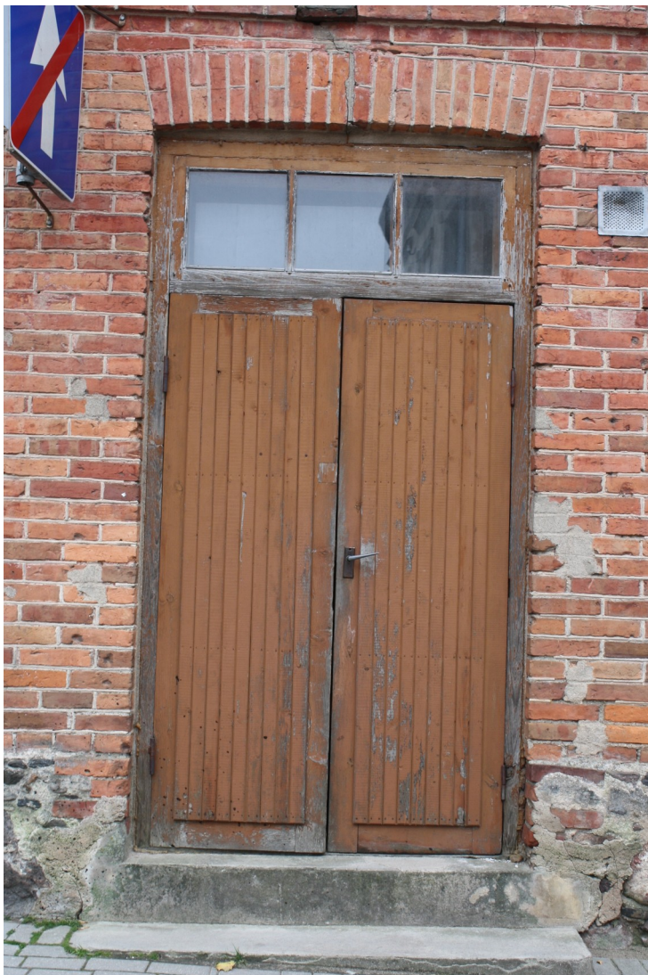
Kaarlja_Miilenbaha_7_88010130115001_durvis1 Sākotnējā (19.gs.4.cet.) durvju aploda ar virslogu. Vērtnes – 20.gs.2.p.
