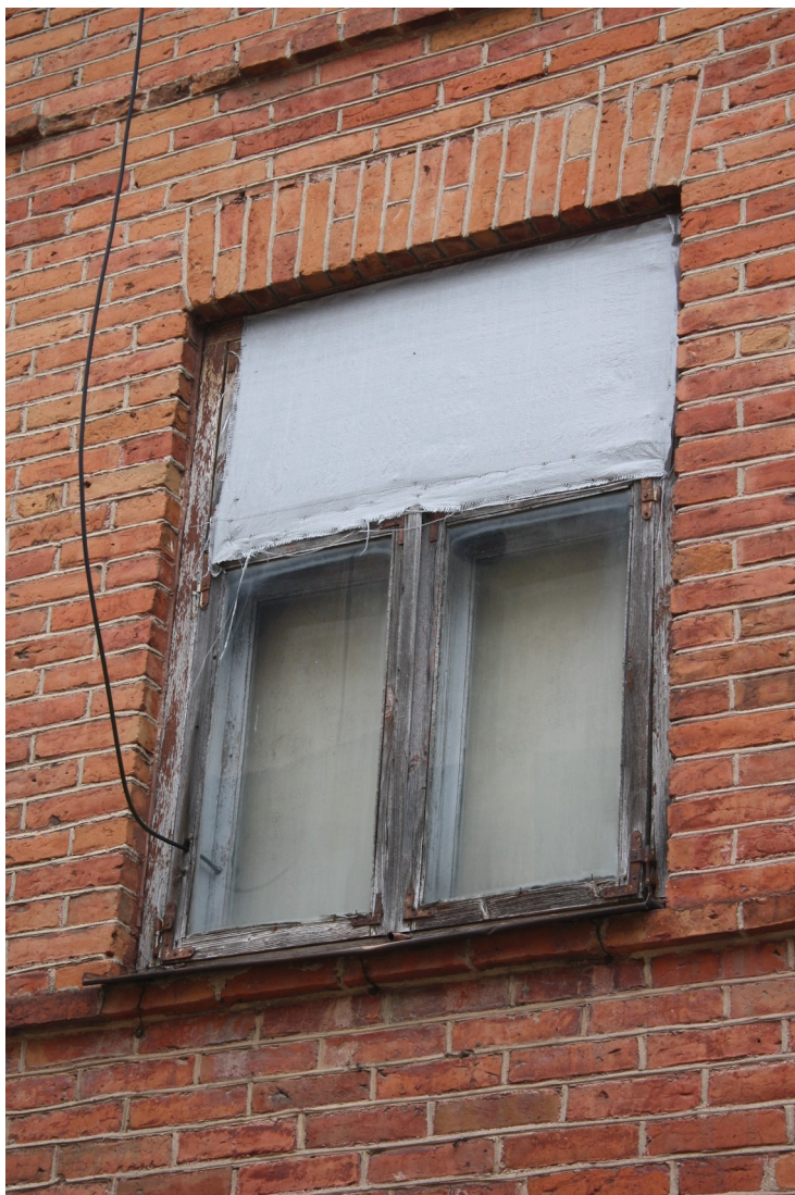
Kaarlja_Miilenbaha_7_88010130115001_logs2 Sākotnējais (19.gs.4.cet.) logs ar oriģinālo aprīkojumu gala fasādē.
