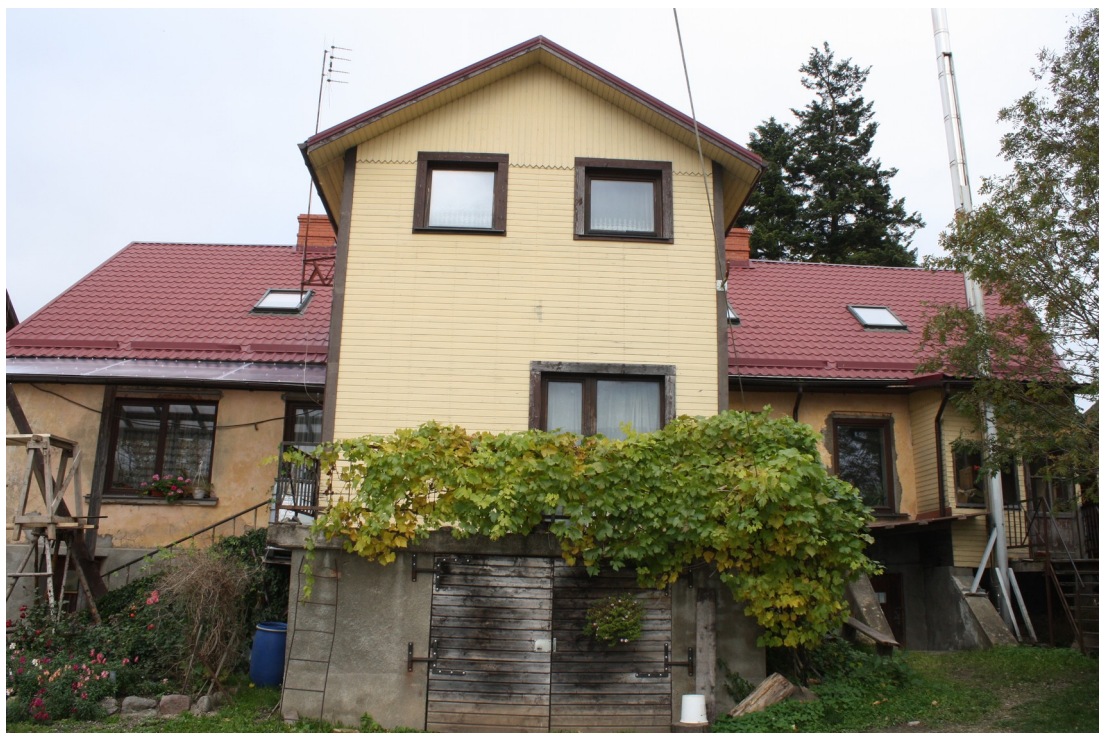
Kaarlja_Miilenbaha_9_88010130118001_fasade4 Skats uz ēku no dienvidrietumiem. Redzamas 20.gs.2.p./21.gs. piebūves.
