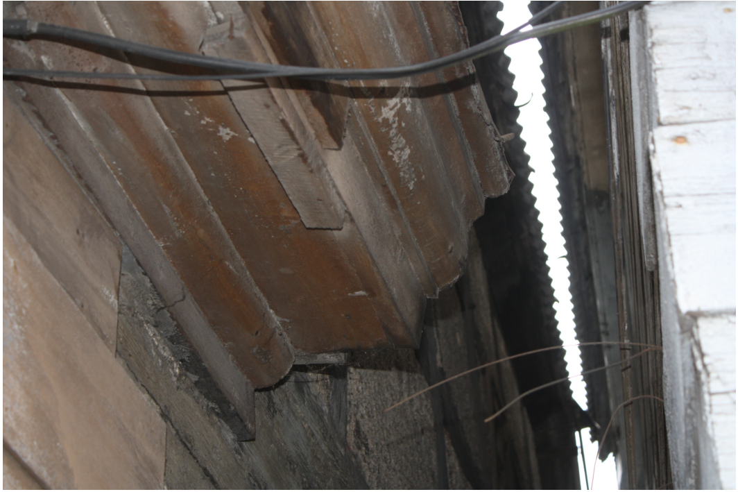
Kaarlja_Miilenbaha_10_88010130074001_dzega2 Vēsturiska dzega.
