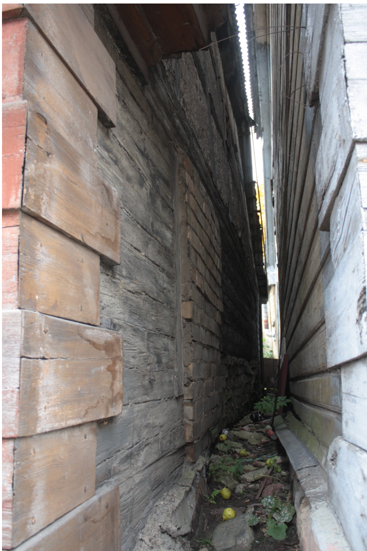
Kaarlja_Miilenbaha_10_88010130074001_fasade6 Ēkas dienvidaustrumu fasādes fragments ar eksponētu sākotnējo guļbaļķu sienu un zelmiņa pildrežģi.
