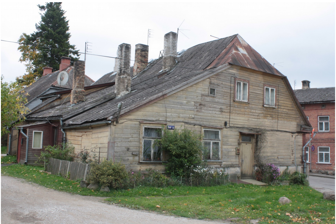
Kaarlja_Miilenbaha_10_88010130074001_fasade3 Skats uz ēku no ziemeļiem. Redzamas vēsturiskās pagalma piebūves.
