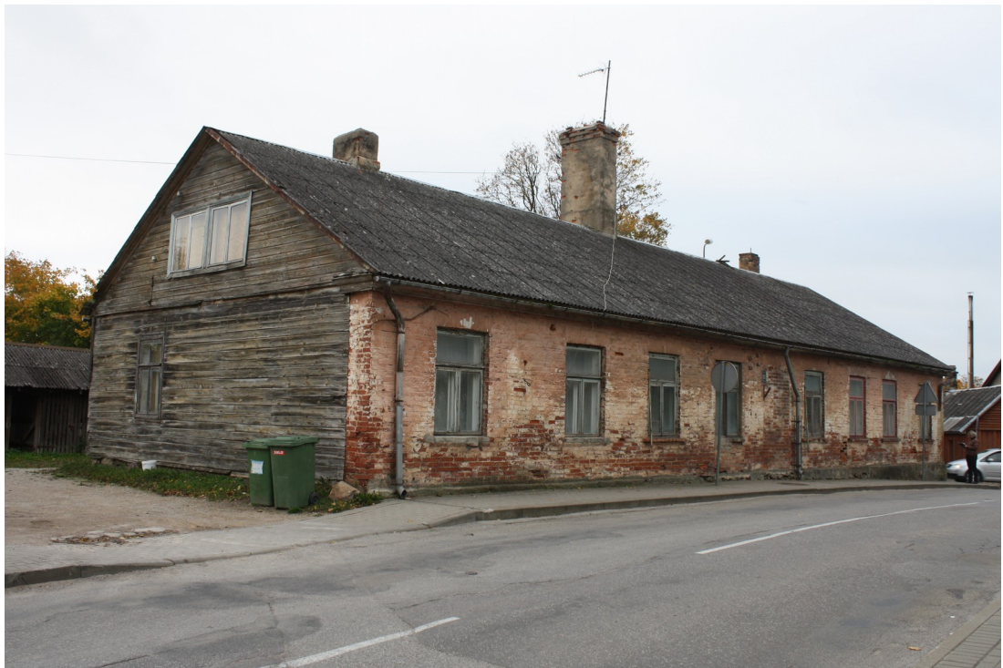
Kaarlja_Miilenbaha_11_88010130113001_fasade2 Skats uz ēku no austrumiem.
