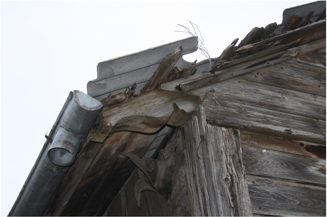
Kaarlja_Miilenbaha_11_88010130113001_fragments2 20.gs.1.cet. dekoratīvi griezts spāres gals.
