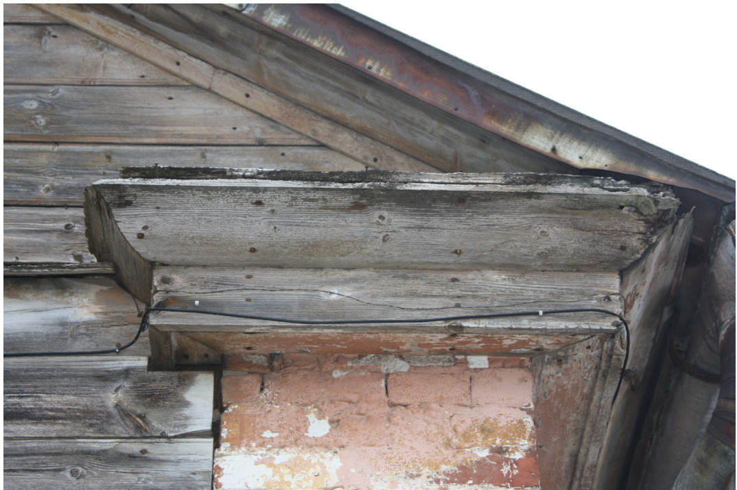
Kaarlja_Miilenbaha_11_88010130113001_dzega1 20.gs.1.cet. dēļu dzega.
