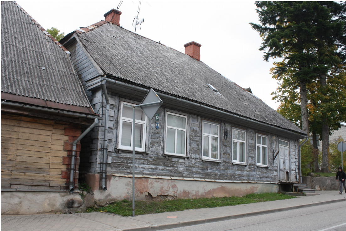
Kaarlja_Miilenbaha_12_88010130075001_fasade1 Skats uz ēku rietumiem.
