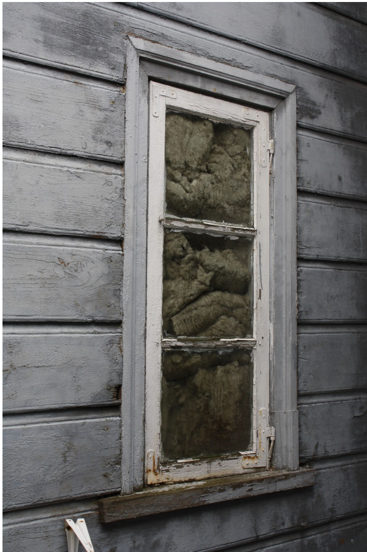
Kaarlja_Miilenbaha_12_88010130075 001_logs1 Sākotnējs (19.gs.3.cet.) logs ar oriģinālo aprīkojumu un ailas segļistēm. Fasādei sākotnējie dēļi.
