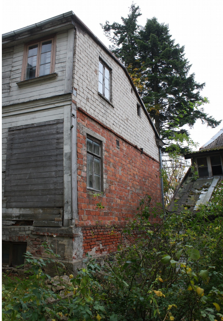
Kaarlja_Miilenbaha_14_88010130076 001_fasade4 Ielas korpusa ziemeļrietumu fasāde, kas sekundāri apmūrēta (?).
