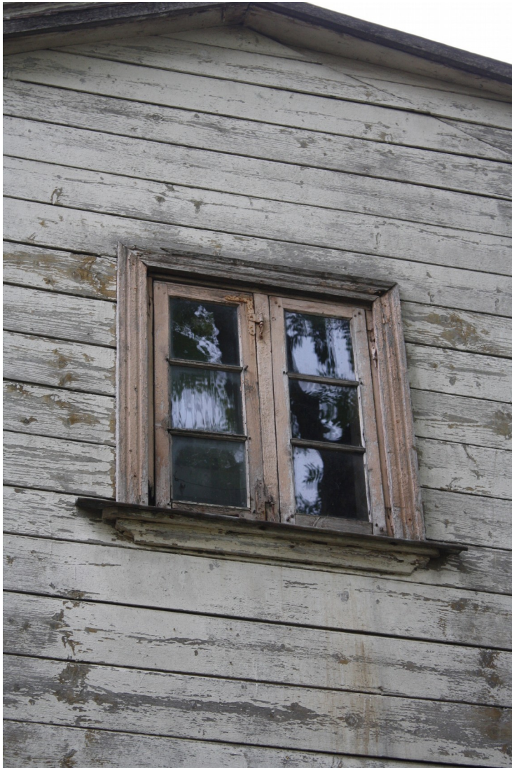
Kaarlja_Miilenbaha_14_88010130076001_logs2 Sākotnējs (1874.g.) logs ar oriģinālo aprīkojumu.
