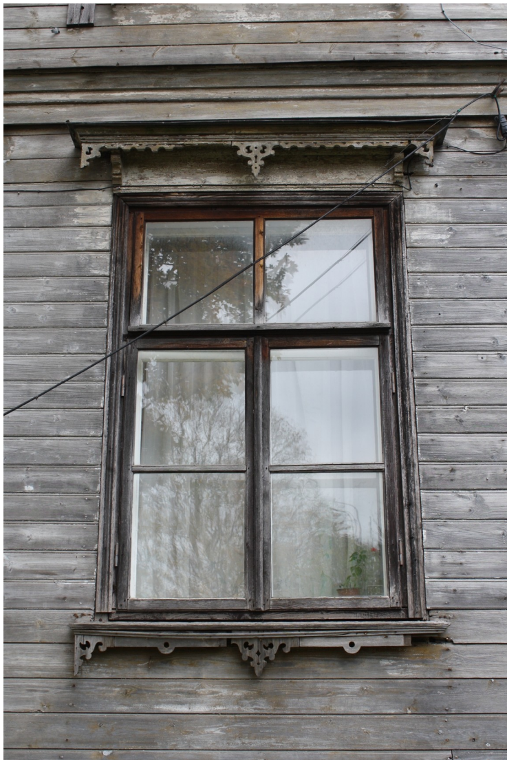
Kaarlja_Miilenbaha_14_88010130076001_fragments7 Sākotnējā (1874.g.) fasādes un logailas apdare. Logs – 20.gs.2.p., kas veidots kā sākotnējā atdarinājums.
