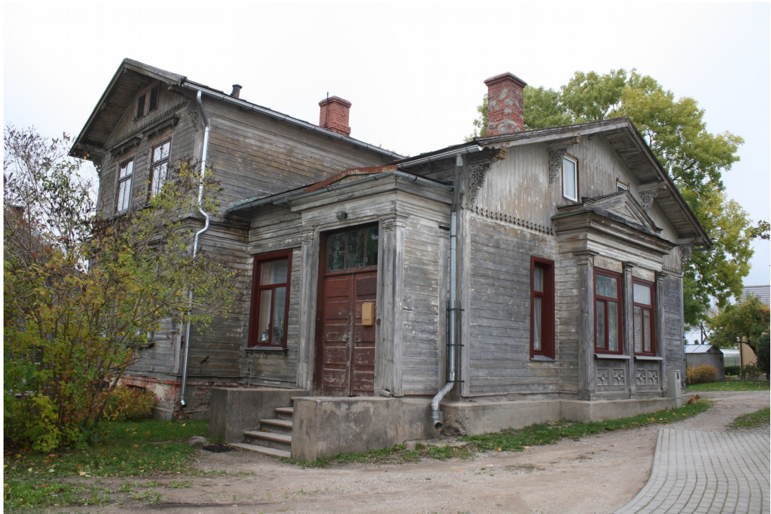
Kaarlja_Miilenbaha_14_88010130076001_fasade9 Skats uz ēku no dienvidaustrumiem.
