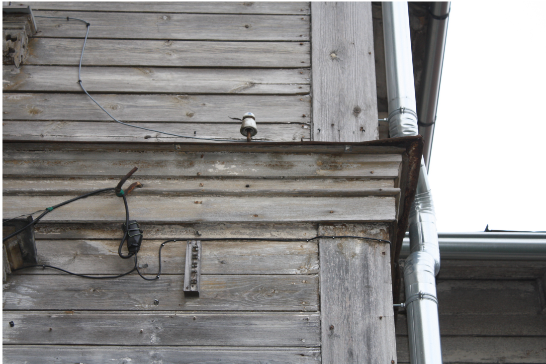
Kaarlja_Miilenbaha_14_88010130076001_fragments2 Fasādes sākotnējā (1874.g.) apdare.
