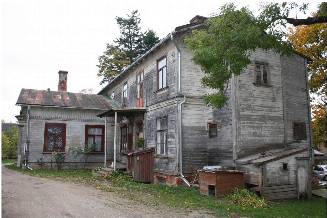
Kaarlja_Miilenbaha_14_88010130076001_fasade6 Skats uz ēku no ziemeļaustrumiem. Priekšplānā redzama vēsturiska vienstāva piebūve.
