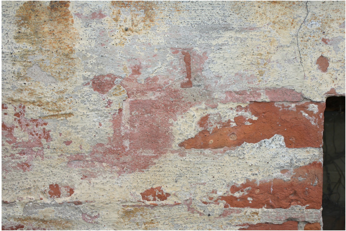
Kaarlja_Miilenbaha_14_88010130076001_apdare1 Sākotnēja (1874.g.) cokola apdare – apmetuma pārziēdums un ķieģeļu mūrējuma imitācijas krāsojums.
