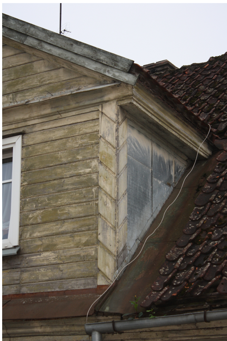
Kaarlja_Miilenbaha_15_88010130111 001_fragments2 Sākotnēja (1876.-1884.g.) mezonīna apdare un lizēna. Skārda apšuvums sekundārs.
