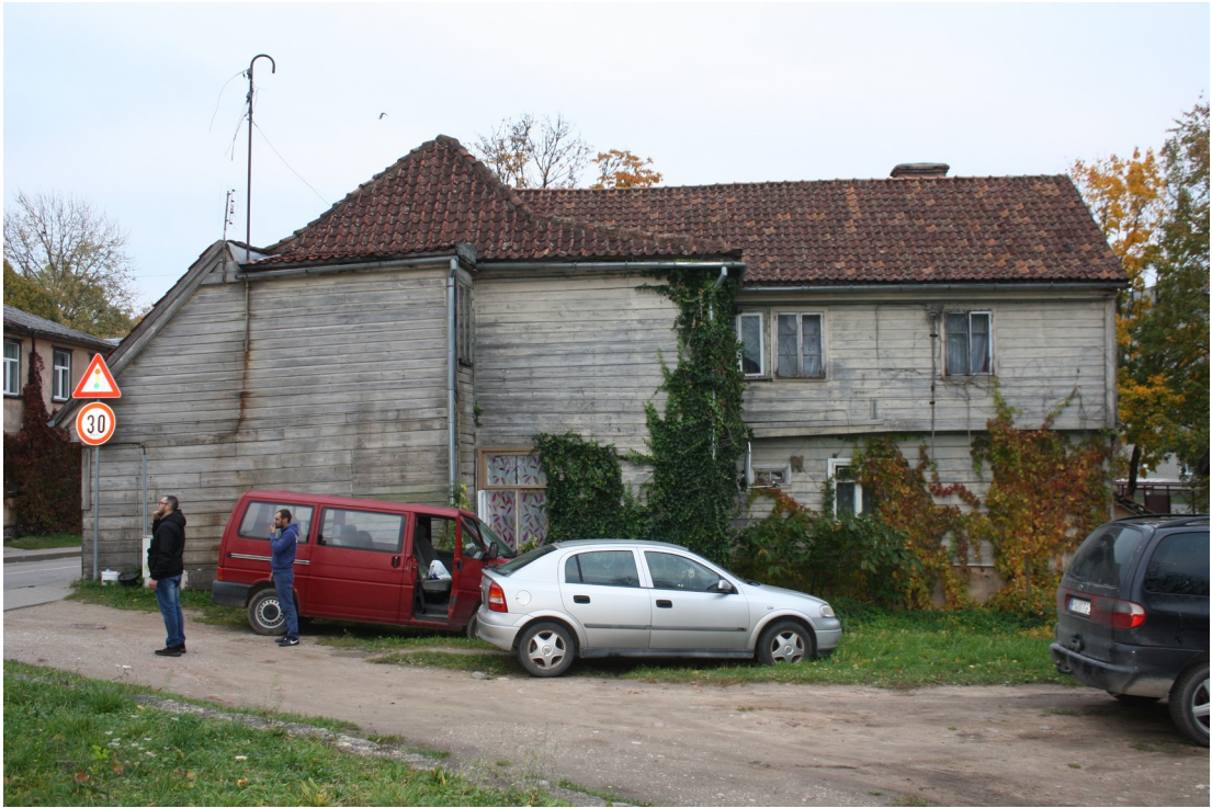
Kaarlja_Miilenbaha_15_88010130111001_fasade3 Skats uz ēku no rietumiem.
