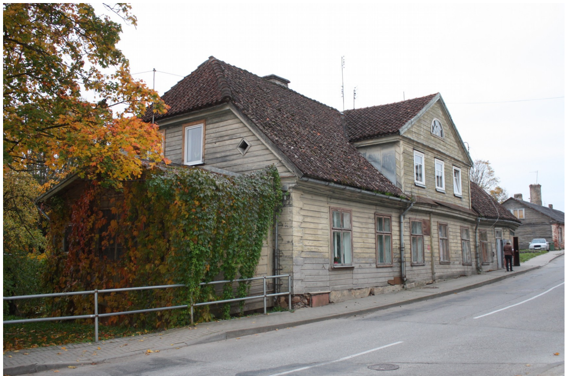
Kaarlja_Miilenbaha_15_88010130111001_fasade2 Skats uz ēku no austrumiem.
