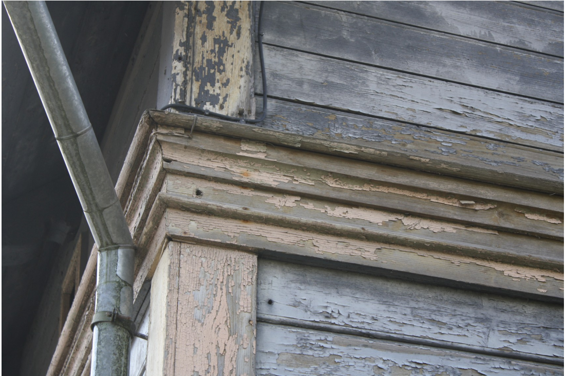
Kaarlja_Miilenbaha_17_88010130050001_fragments8 Sākotnēja fasāžu apdare un starpdzega.
