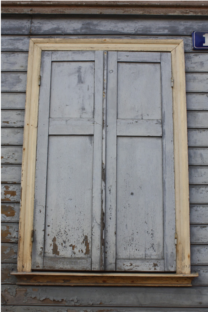
Kaarlja_Miilenbaha_17_88010130050 001_slegis1 Sākotnējs slēģis.
