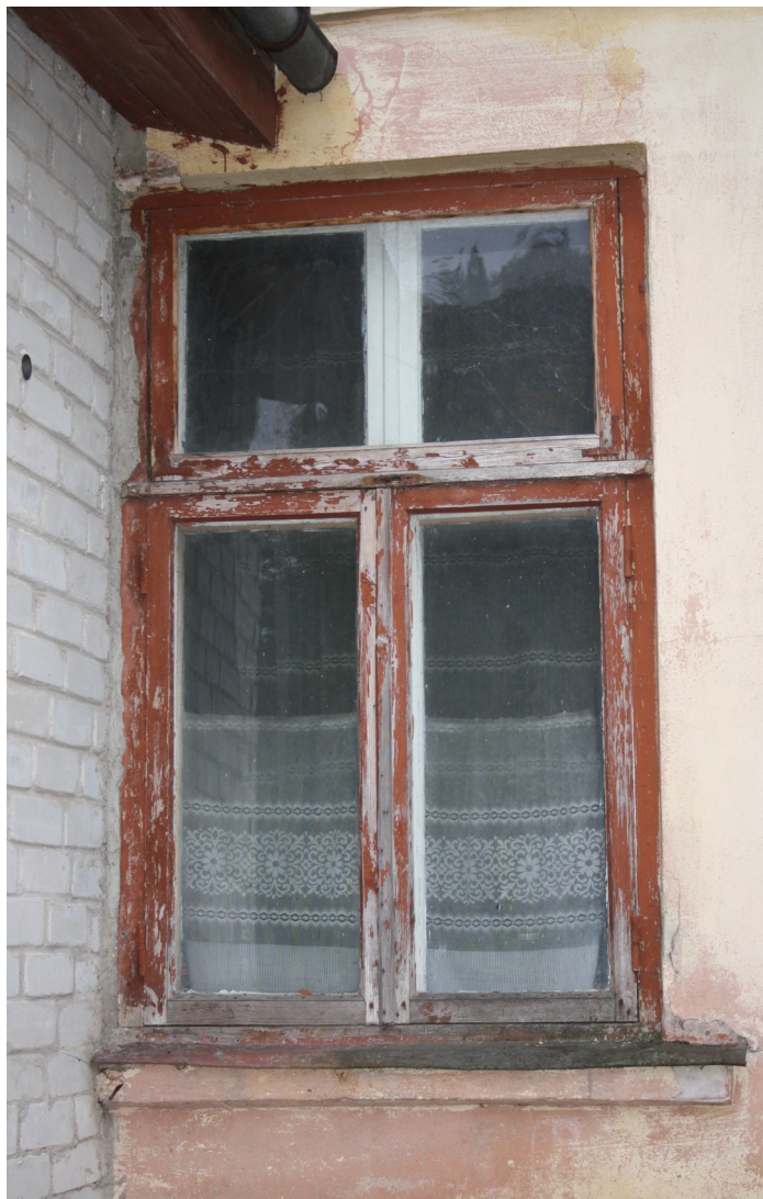
Kaarlja_Miilenbaha_18_88010130017 001_logs1 Sākotnējs (19./20.gs. mija) logs ar oriģinālo aprīkojumu un mūra palodzi.
