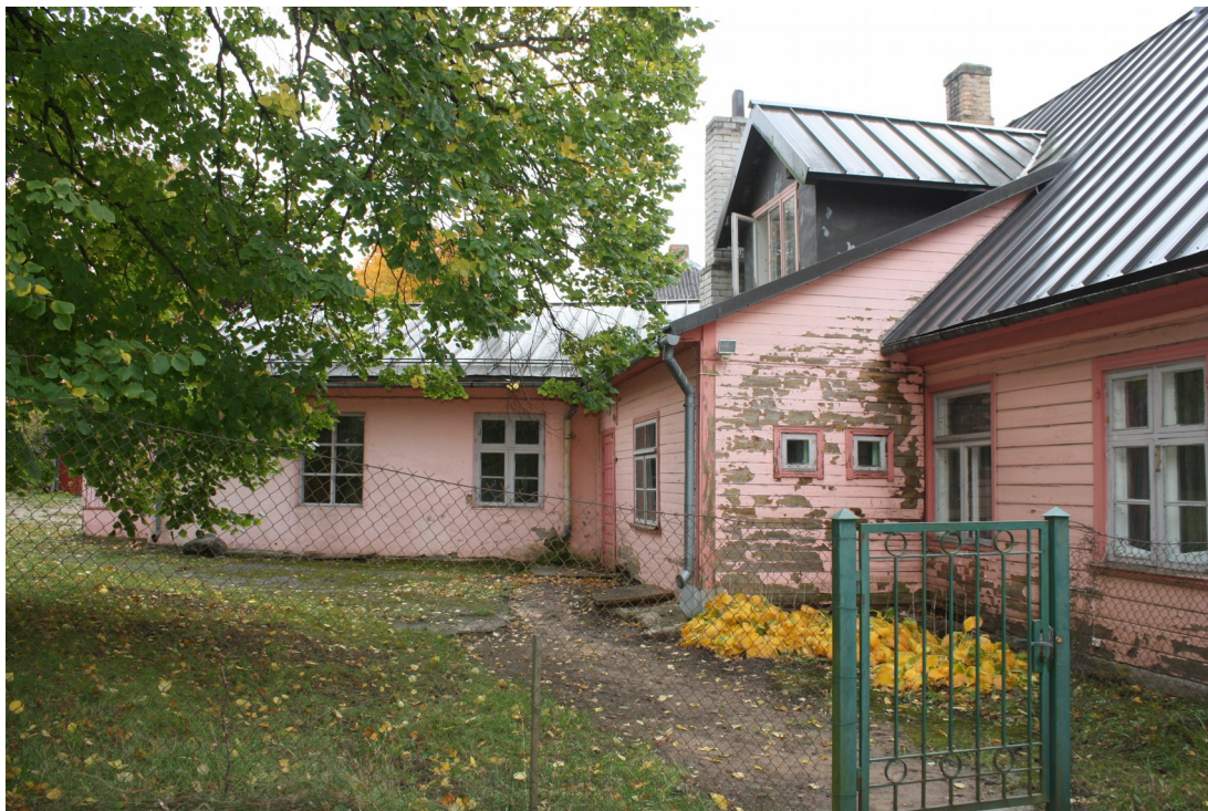
Kaarlja_Miilenbaha_20_88010130018001_fasade5 Skats uz ēku no ziemeļrietumiem. Redzamas 20.gs.1.cet. piebūves un 20.gs.20.,30.gadu jumta izbūve.
