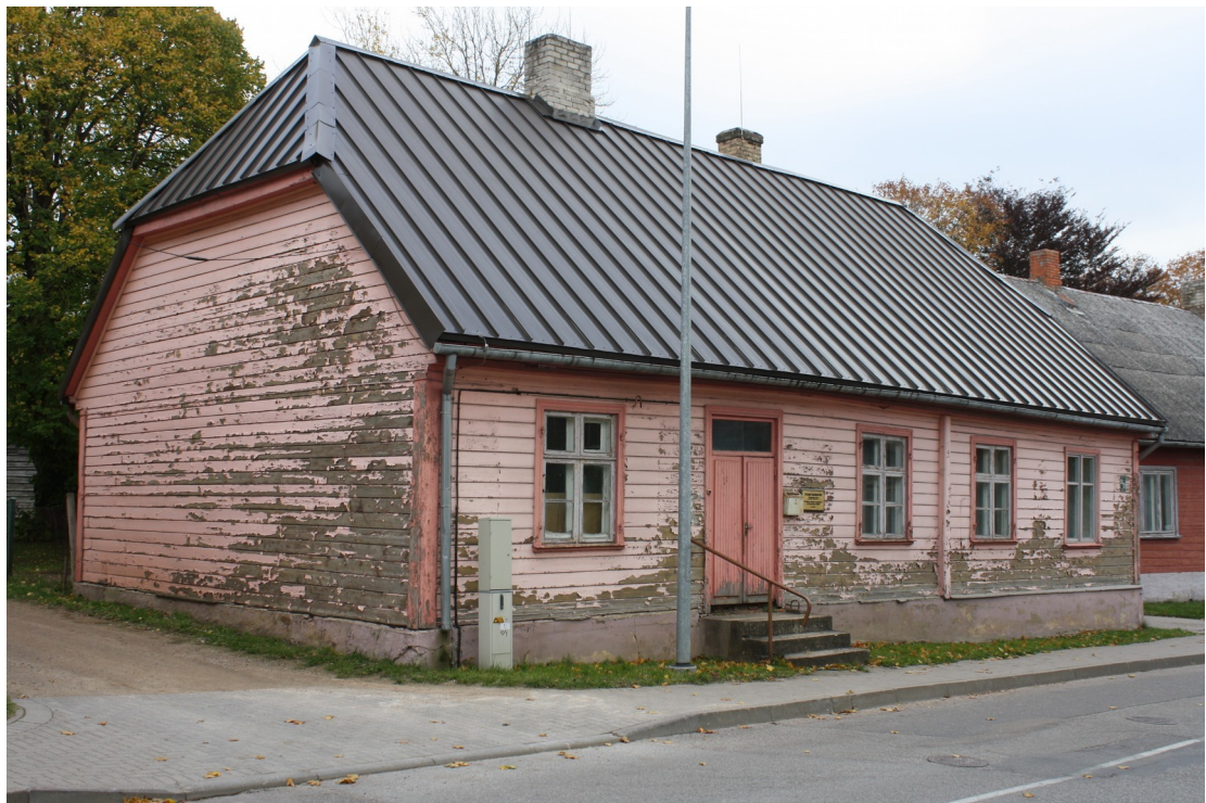
Kaarlja_Miilenbaha_20_88010130018001_fasade2 Skats uz ēku no rietumiem.
