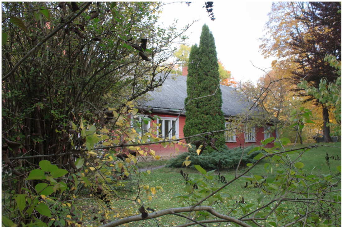
Kaarlja_Miilenbaha_22_88010130103001_fasade4 Dienvidaustrumu fasādes fragments.
