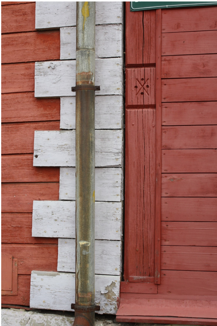
Kaarlja_Miilenbaha_22_88010130103 001_fragments3 Vēsturiski stūra rusti un 20.gs.20.,30.gadu lieveņa balsts.
