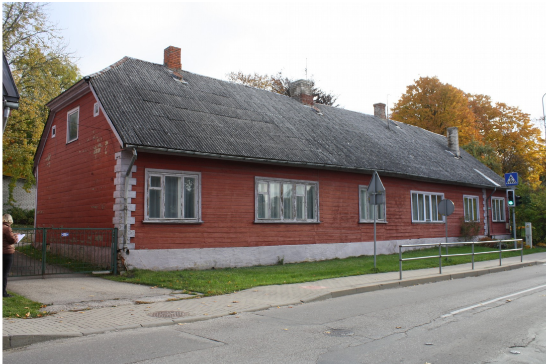
Kaarlja_Miilenbaha_22_88010130103001_fasade1 Skats uz ēku no rietumiem.
