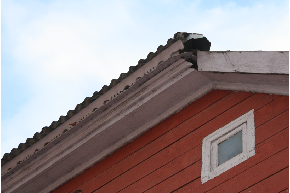
Kaarlja_Miilenbaha_22_88010130103001_fragments1 Sākotnējs (19.gs.3.cet.) lodziņš ar oriģinālo aprīkojumu un apmalēm, dēļu dzega un robdēlis.
