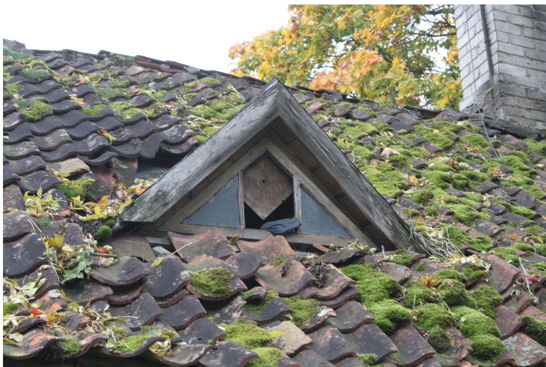
Kaleeju_4_88010130122002_fasade4 Vēsturisks jumta logs.
