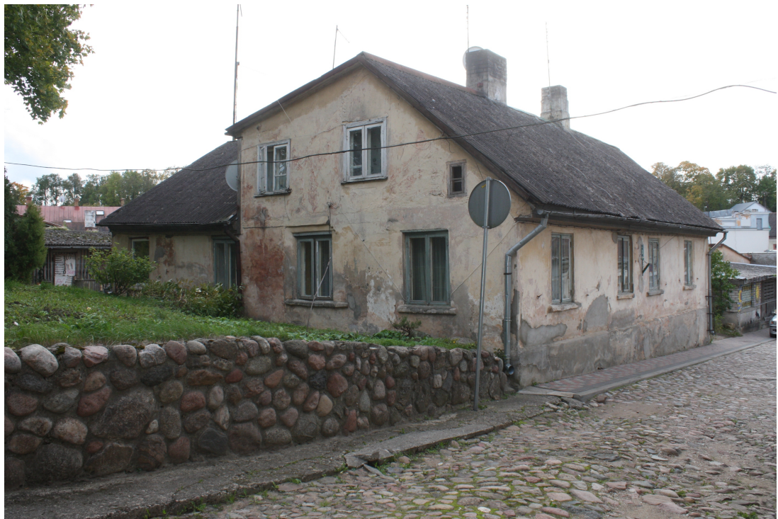
Kalna_1_88010120196001_fasade2 Skats uz ēku no ziemeļaustrumiem. Zudusi sākotnēja piebūve pie ēkas gala fasādes. Jumta daļa paaugstināta 19./20.gs.mijā.
