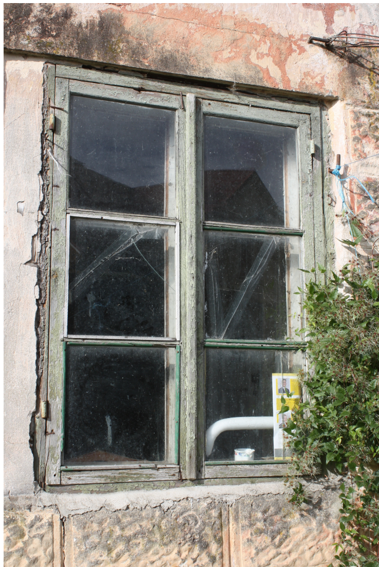
Kalna_1_88010120196001_logs1 Sākotnējs (?) logs piebūves gala fasādē
