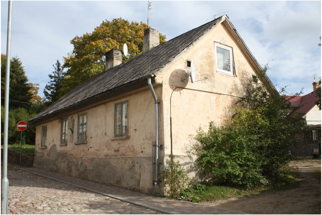
Kalna_1_88010120196001_fasade1 Skats uz ēku no ziemeļrietumiem.
