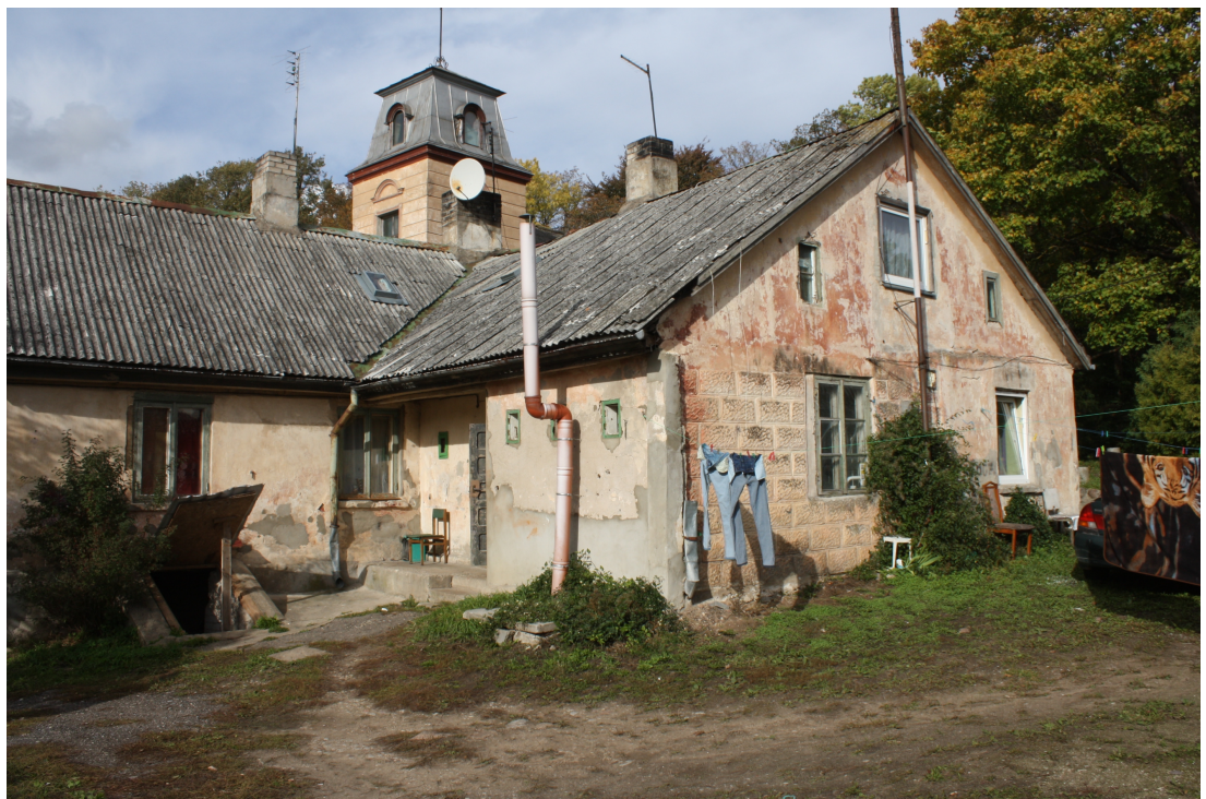
Kalna_1_88010120196001_fasade4 Skats uz ēku no dienvidiem. Piebūves gala fasādē esošās apdares plāksnes ēku apdarē Talsos izmantotas laikā no 1920.gadiem. Domājams, ka konkrētajā gadījumā –1959.gadā.
