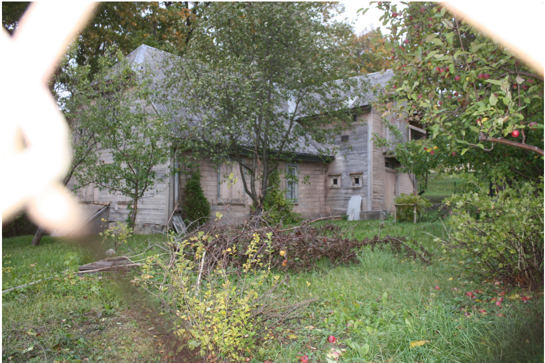
Kalna_3_88010120195001_fasade4 Skats uz ēku no dienvidrietumiem (gruntsgabala Lielā ielā 30).
