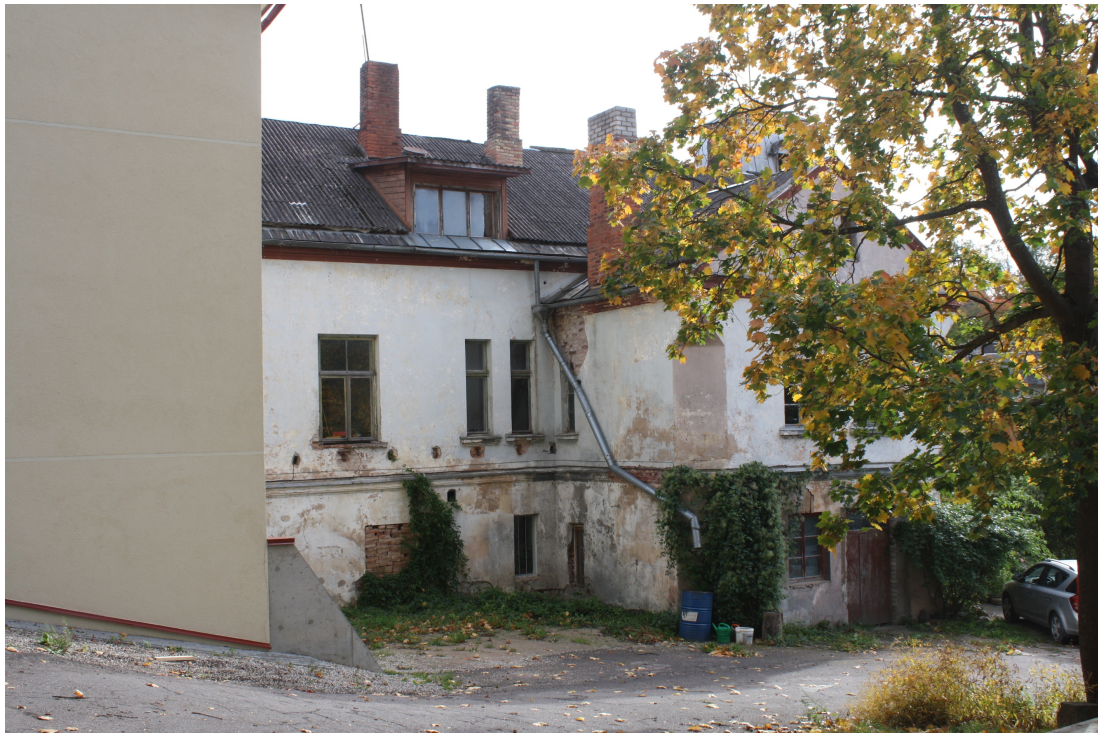
Kalna_4_88010120197001_fasade3 Skats uz ēku no ziemeļaustrumiem. Jumta izbūve – 20.gs.2.puse.
