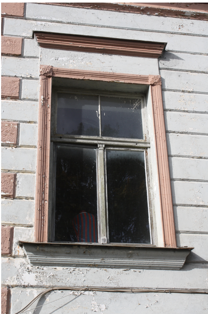
Kalna_4_88010120197001_logs1 Sākotnējā logailla ar oriģinālo apdari un logu.
