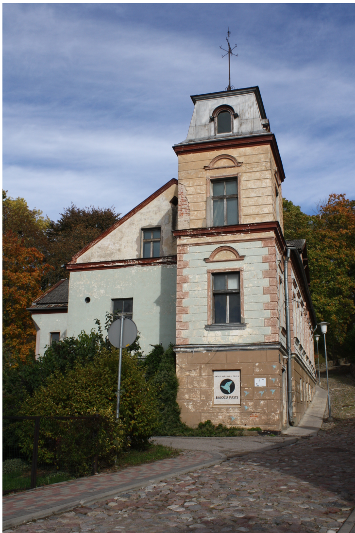
Kalna_4_88010120197001_fasade1 Skats uz ēku no dienvidrietumiem.
