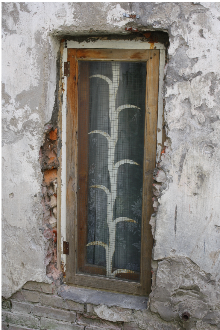
Kalna_4_88010120197001_logs5 Logaīla piebūvē ar, domājams, sākotnējo metāla resti. Vērtnes jaunas.
