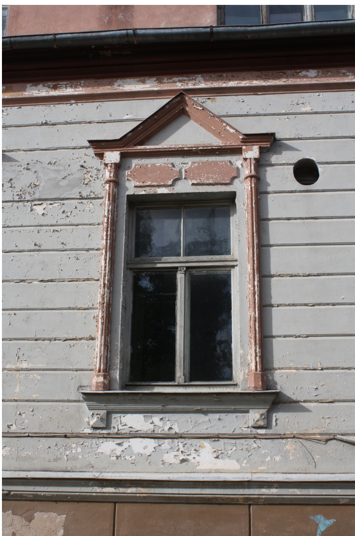
Kalna_4_88010120197001_fragments2 Sākotnējā loga ar oriģinālo apdari un logu.
