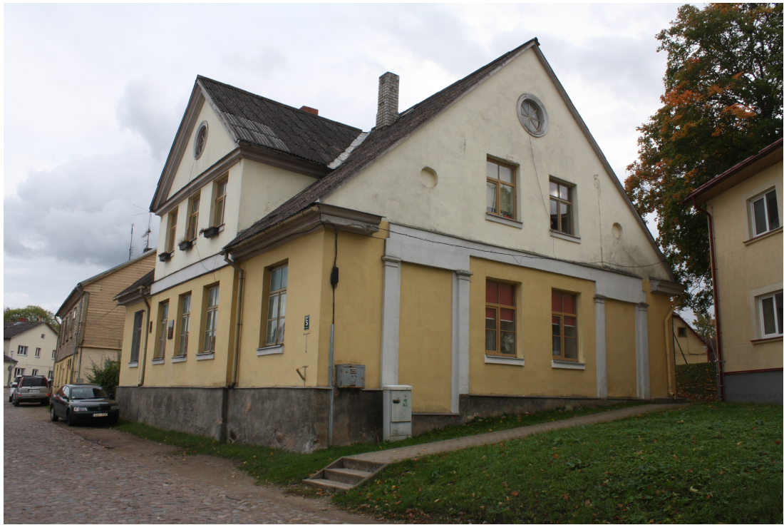
Kalna_5_88010120205001_fasade1 Skats uz ēku no ziemeļrietumiem. Zuduši sandriki virs portāliem. Likvidētas durvis kreisajā pusē.
