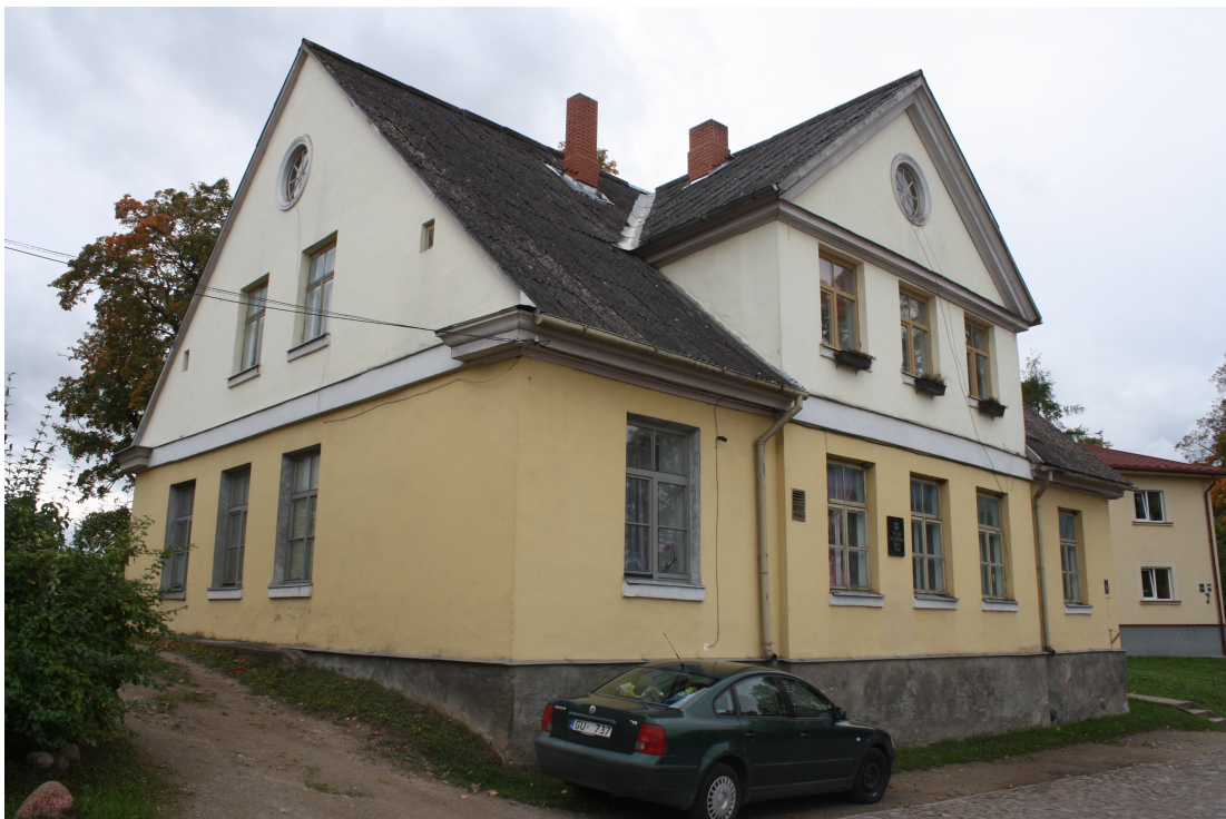
Kalna_5_88010120205001_fasade2 Skats uz ēku no ziemeļaustrumiem.
