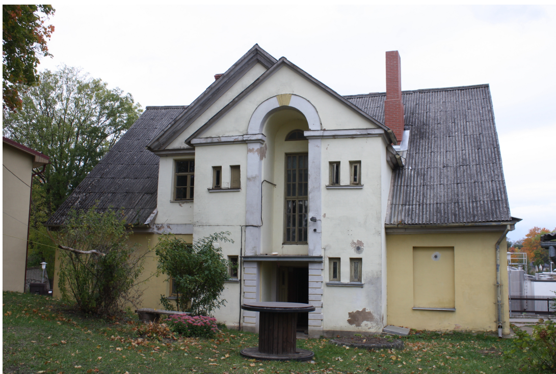
Kalna_5_88010120205001_fasade4 Skats uz ēku no dienvidiem. Priekšplānā esošā piebūve – 1952.gads.
