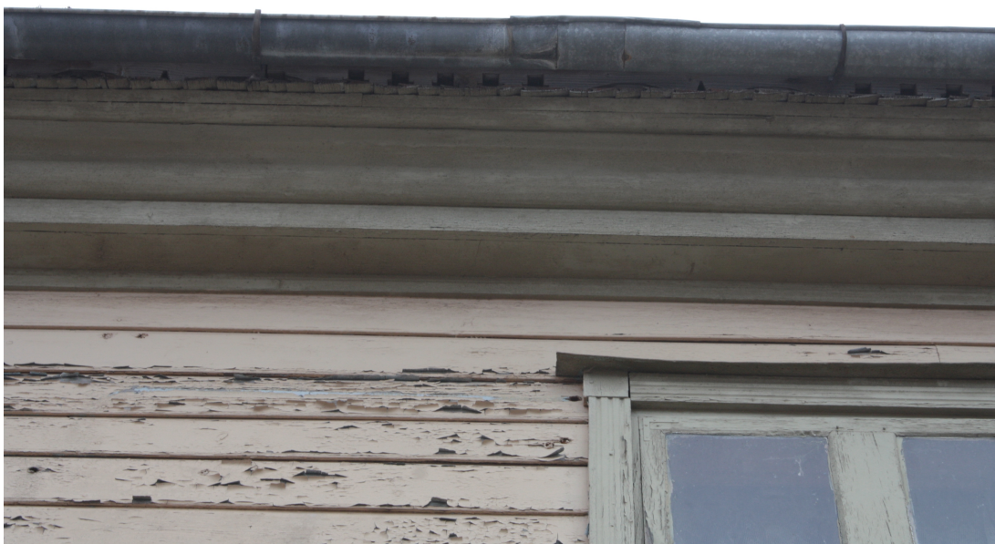
Kalna_7_88010120206001_dzega1 Skats uz vēsturisko dēļu dzegu. Zem esošā seguma saglabājušās vēsturiskās jumta skaidas. Robdēļa datējums nav zināms – vēsturisks vai kopija.
