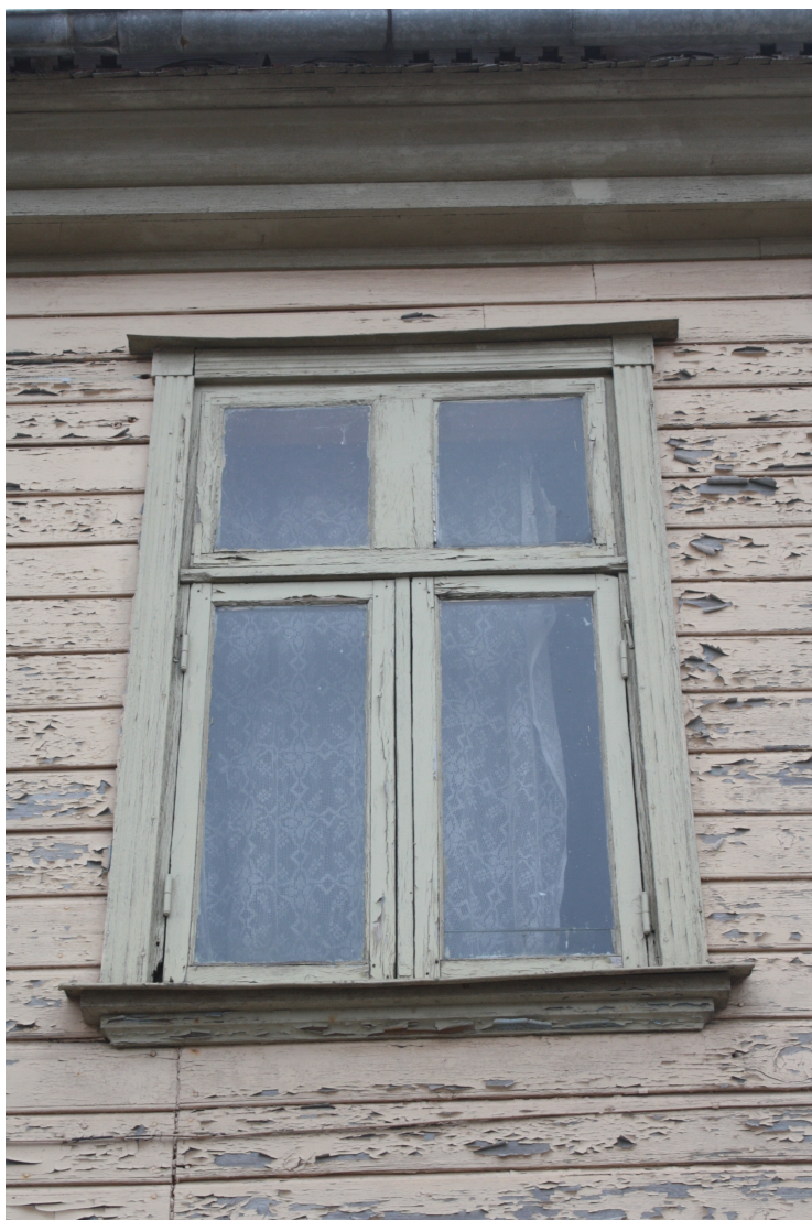
Kalna_7_88010120206001_logs1 Saglabājies 20.gs.20./30.gadu logs ar vēsturisko apdari, aplodu un, domājams, augšējo vētrni.
