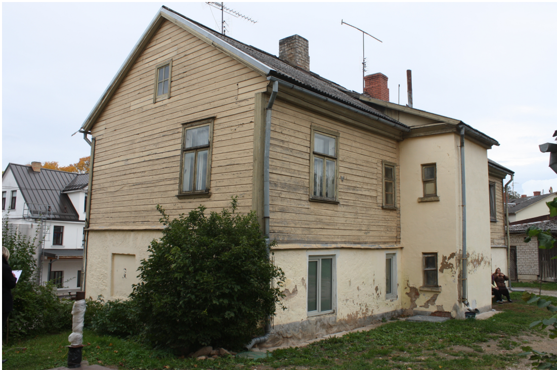
Kalna_7_88010120206001_fasade4 Skats uz ēku no dienvidrietumiem
