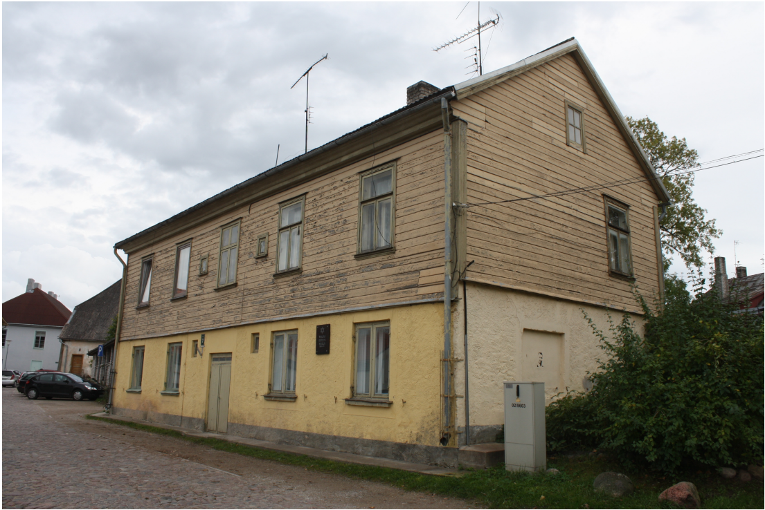
Kalna_7_88010120206001_fasade1 Skats uz ēku no ziemeļrietumiem.
