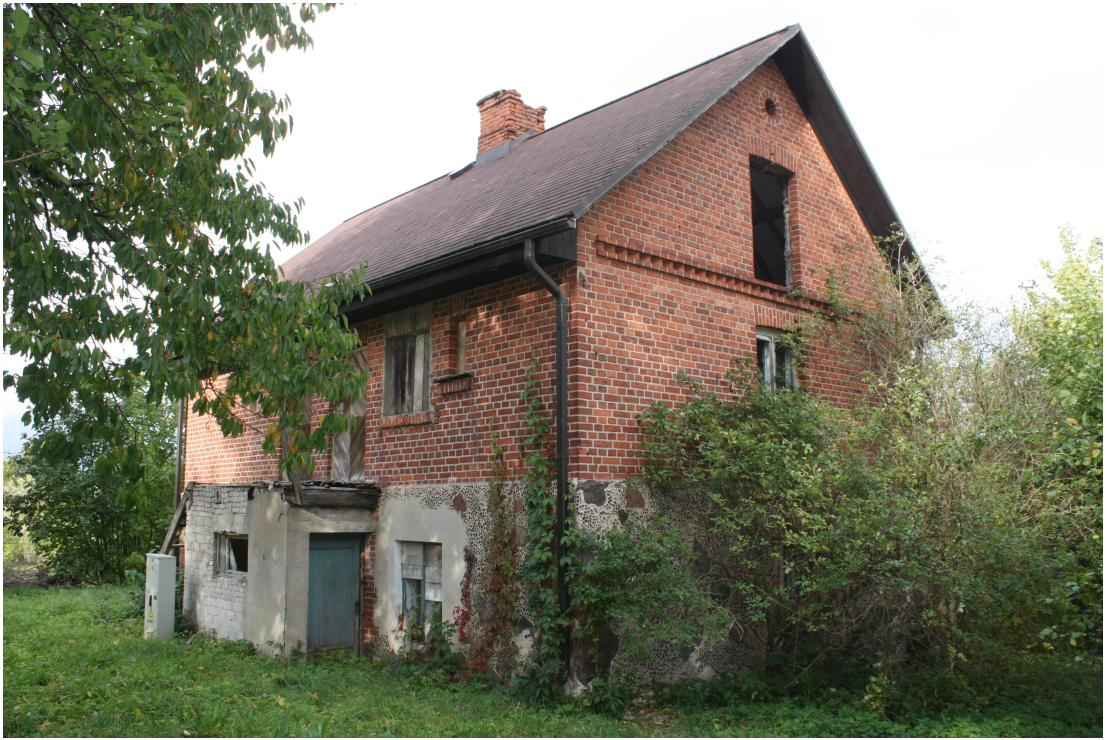
Kalna_8_88010120004004_fasade1 Skats uz ēku no dienvidiem.
