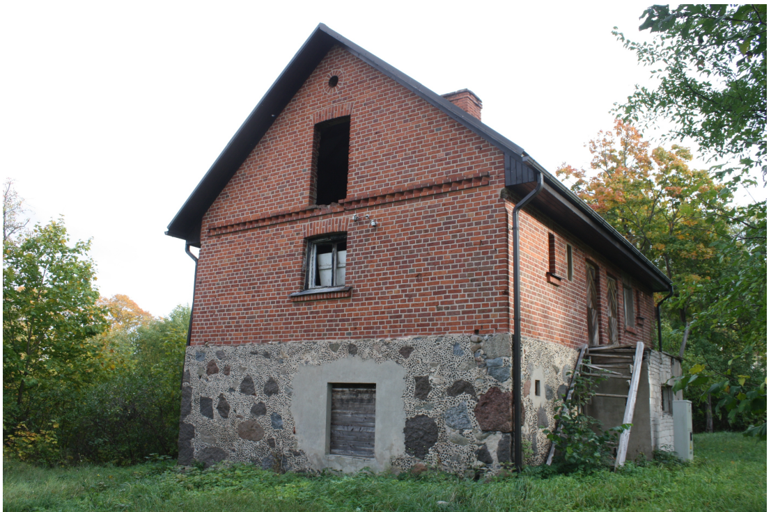
Kalna_8_88010120004004_fasade2 Skats uz ēku no ziemeļiem. Esošais lievenis un logaila cokolstāvā – 20.gs.2.puse.
