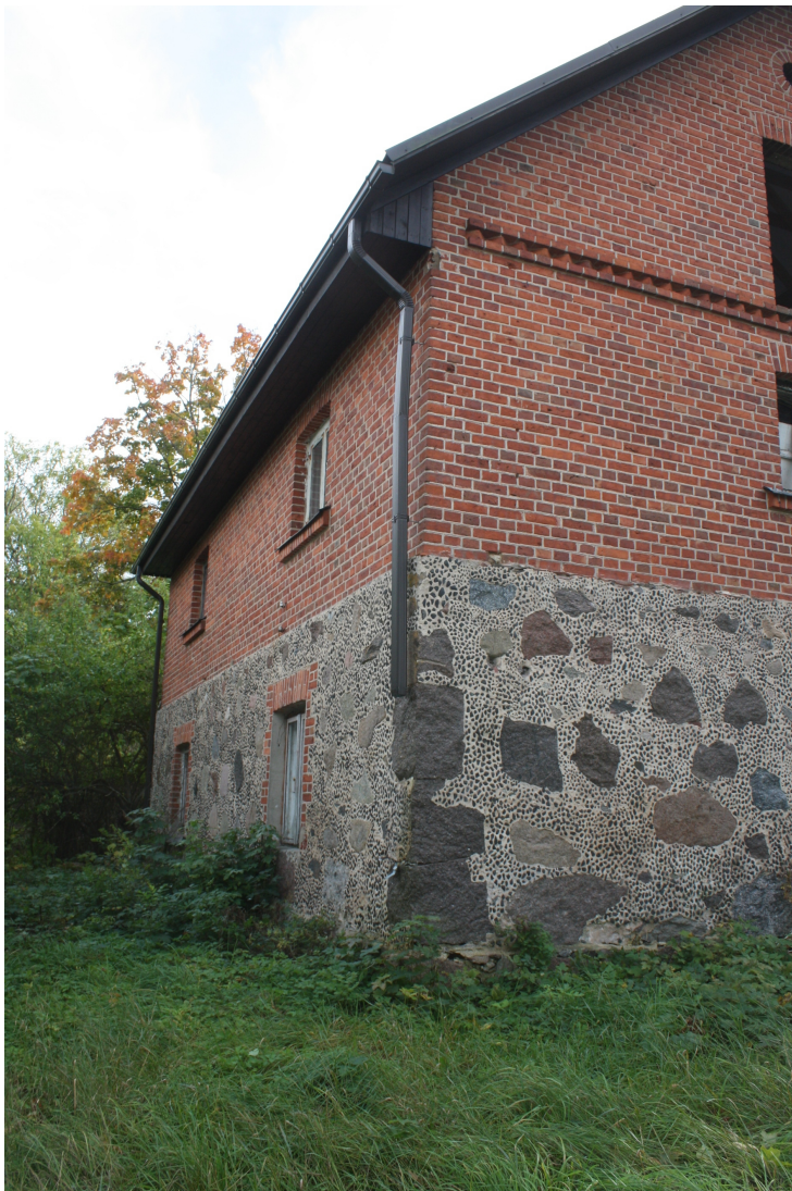
Kalna_8_88010120004004_fasade3 Skats uz ēku no ziemeļaustrumiem.
