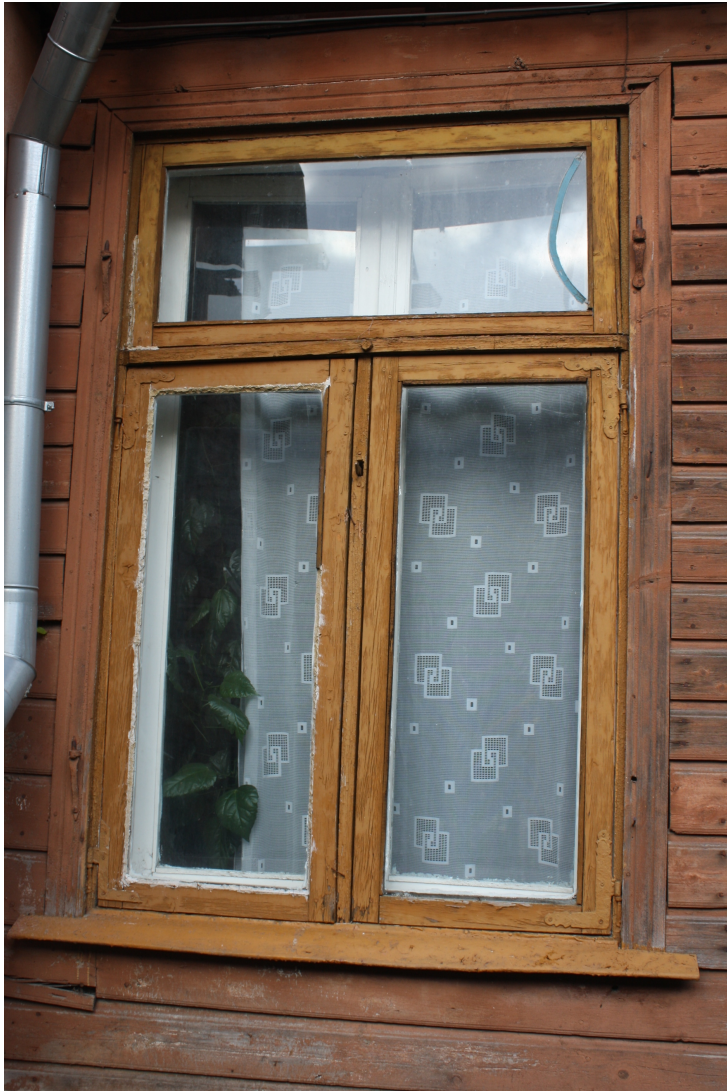
Laidzes_1_88010120213001_logs2 Vēsturisks logs, kam izmantotas 18.gs.2.puses kāšu viras.
