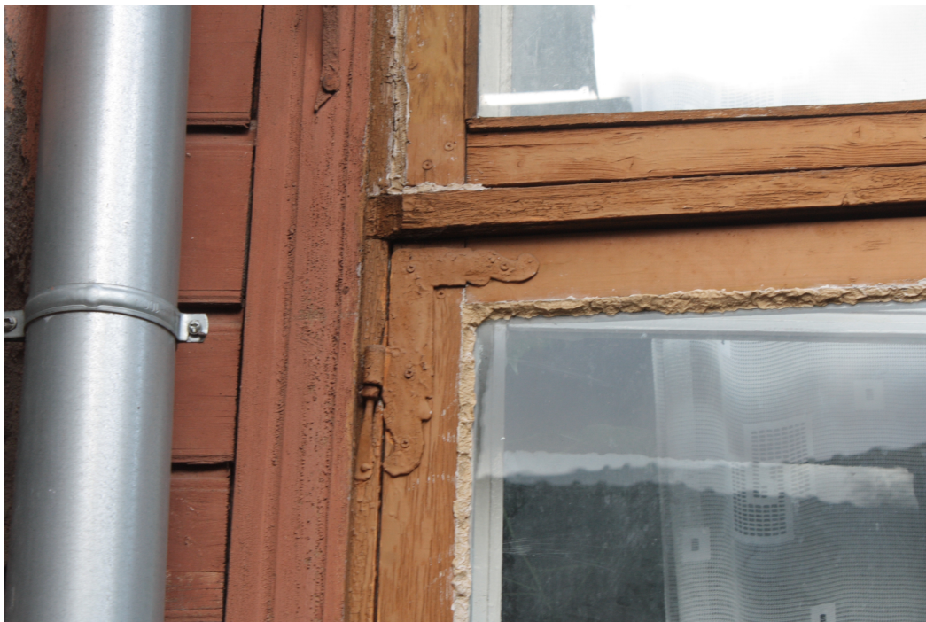
Laidzes_1_88010120213001_logs5 Sekundāri izmantota 18.gs.2.puses kāšu vira.
