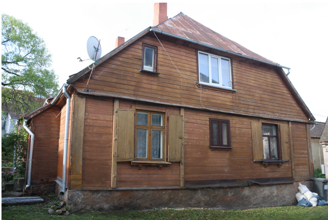
Laidzes_1_88010120213001_fasade3 Ēkas ziemeļaustrumu fasādes kopskats.
