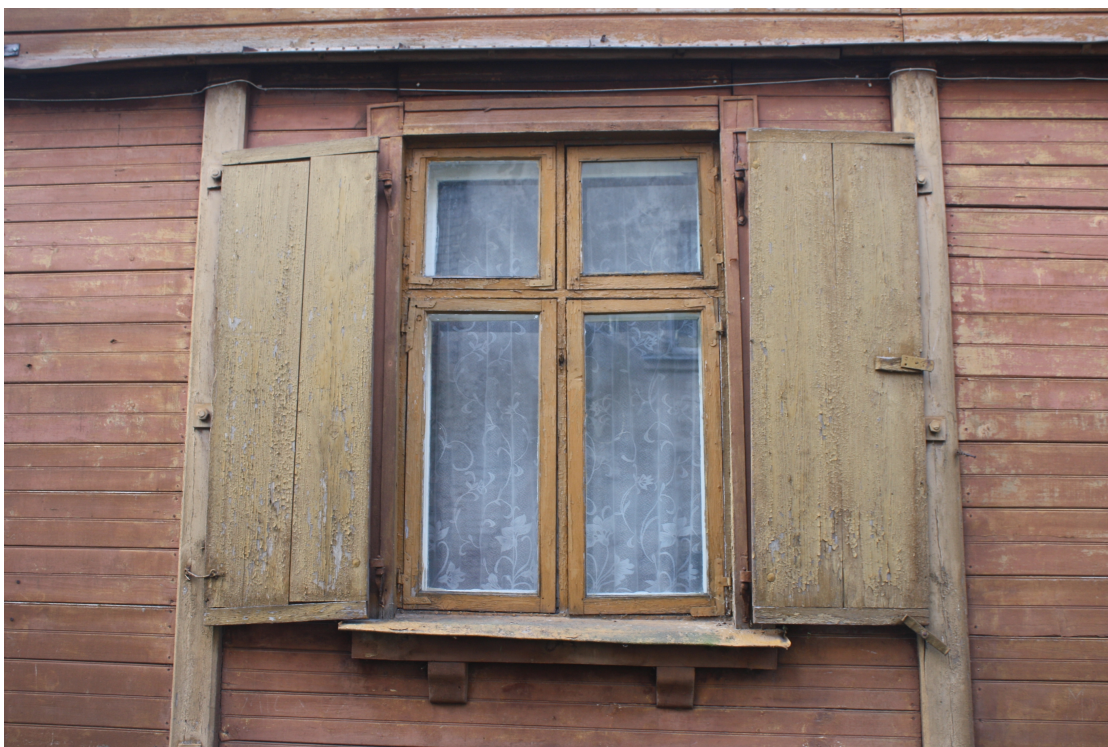
Laidzes_1_88010120213001_slegis1 Vēsturisks logs un slēģi ar oriģinālo aprīkojumu un ailas apdari.
