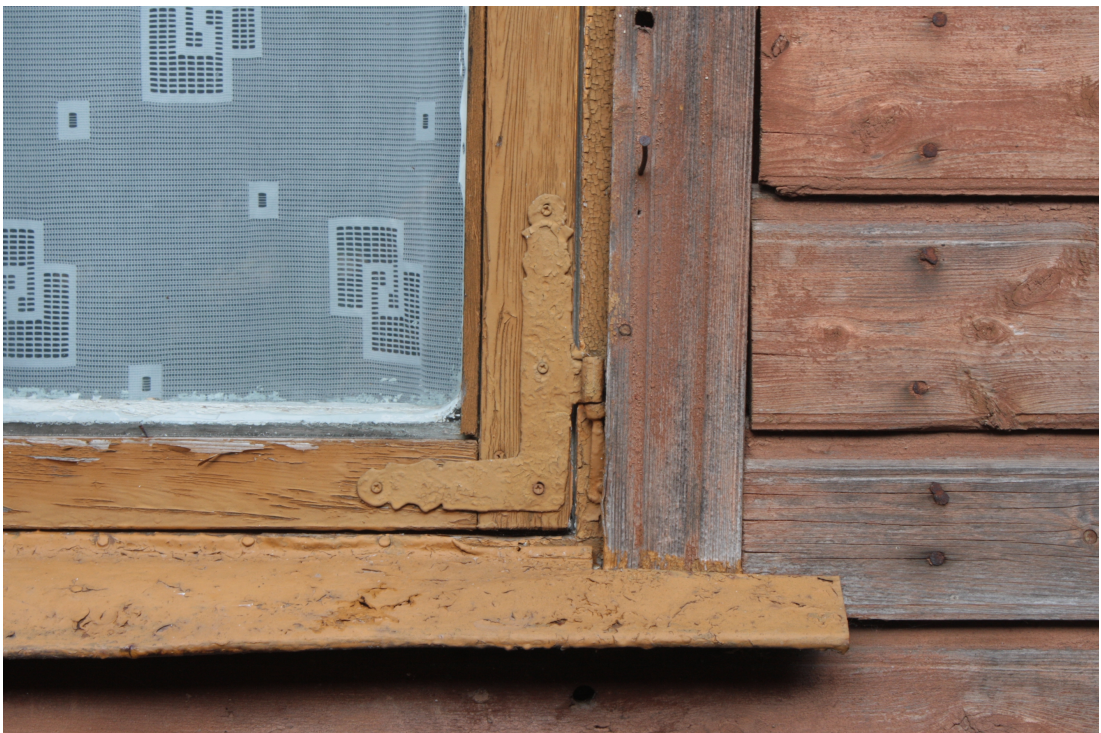
Laidzes_1_88010120213001_logs3 Sekundāri izmantota 18.gs.2.puses kāšu vira.
