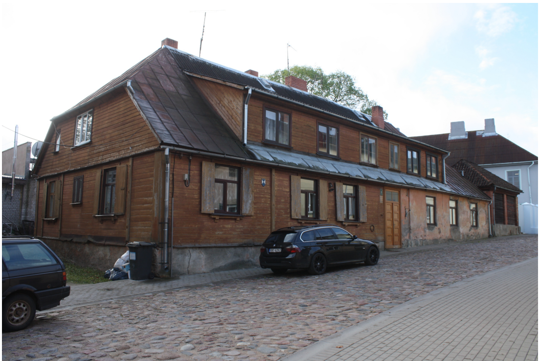
Laidzes_1_88010120213001_fasade1 Skats uz ēku no ziemeļaustrumiem. Jumta izbūve izveidota 20.gs.2.pusē.
