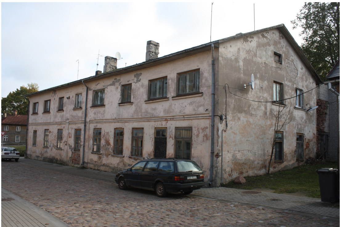
Laidzes_3_5_88010120094001_fasade2 Skats uz ēku no rietumiem. Ēkas 2.stāvs uzbūvēts ap 1960.gadu.
