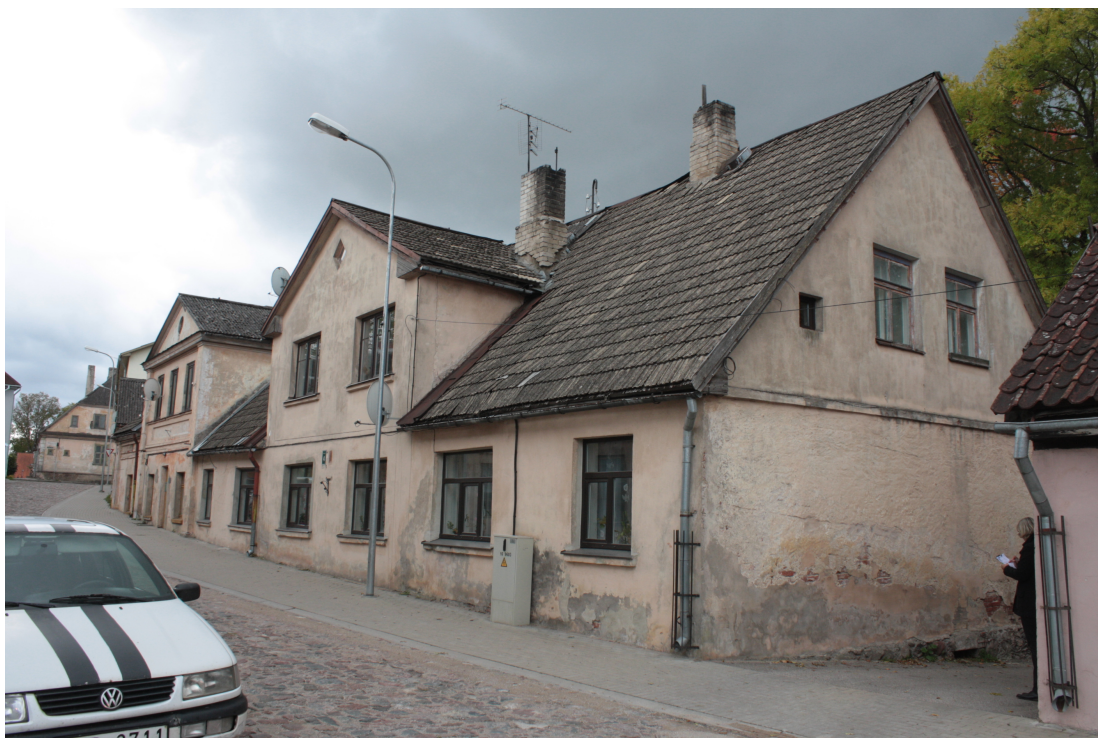
Laidzes_4_88010120080001_fasade4 Skats uz ēku no austrumiem.
