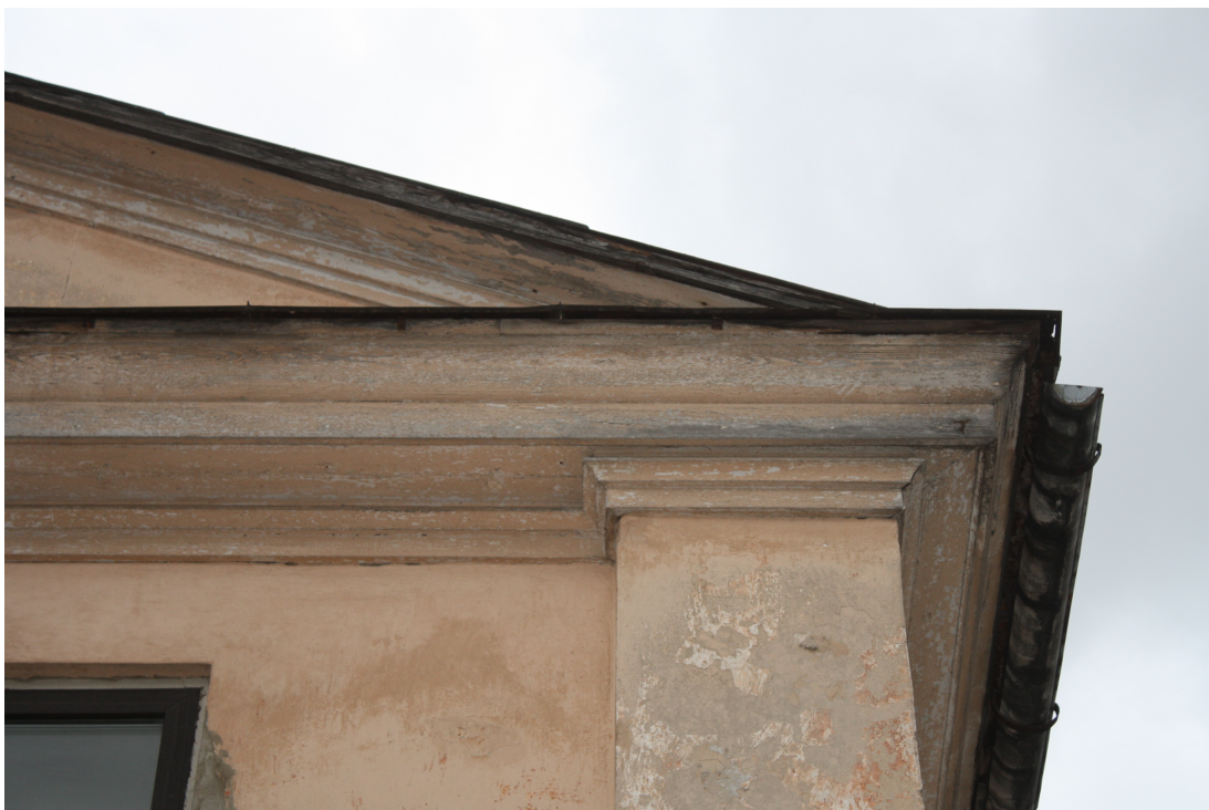
Laidzes_4_88010120080001_dzega1 Sākotnēja (19.gs.4.cet.) dēļu dzega.
