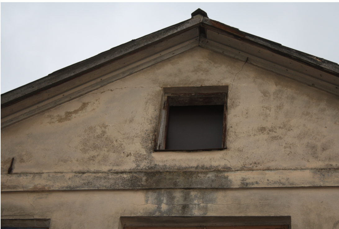
Laidzes_4_88010120080001_fragments1 Sākotnēja (19.gs.4.cet.) loga aploda ar oriģinālajiem viru kāšiem.
