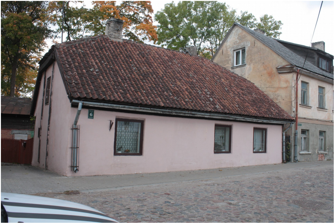
Laidzes_6_88010120093001_fasade1 Skats uz ēku no dienvidiem.
