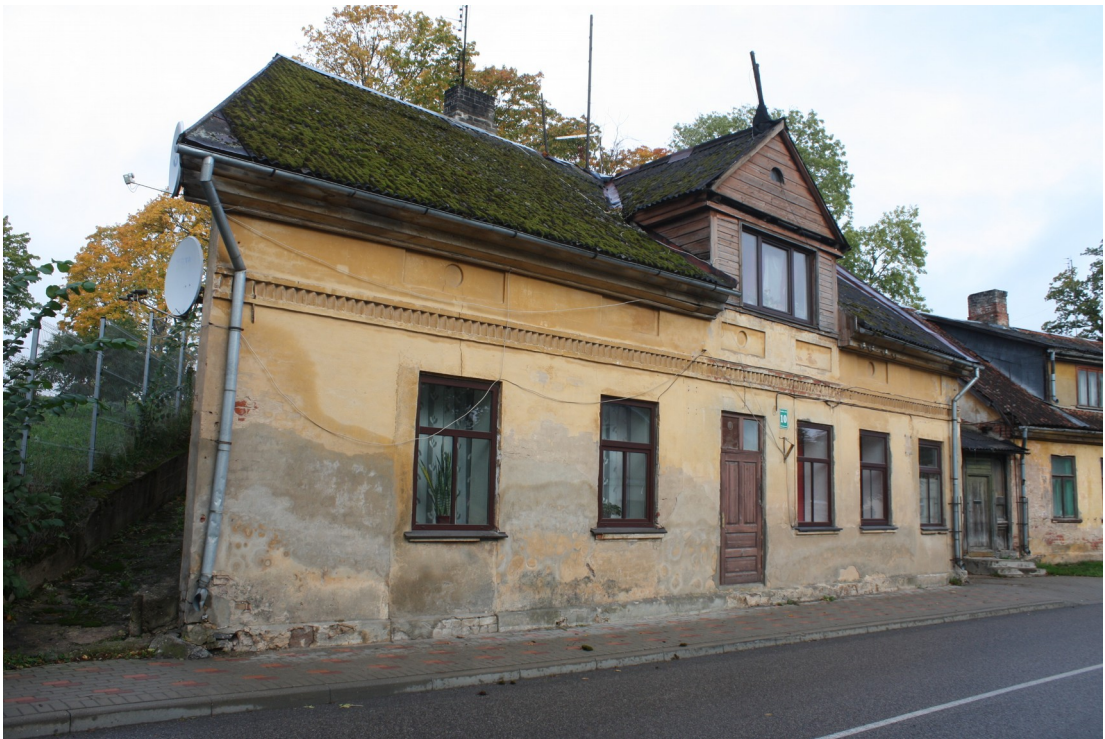
Laidzes_10_88010120216001_fasade2 Skats uz ēku no dienvidaustrumiem.
