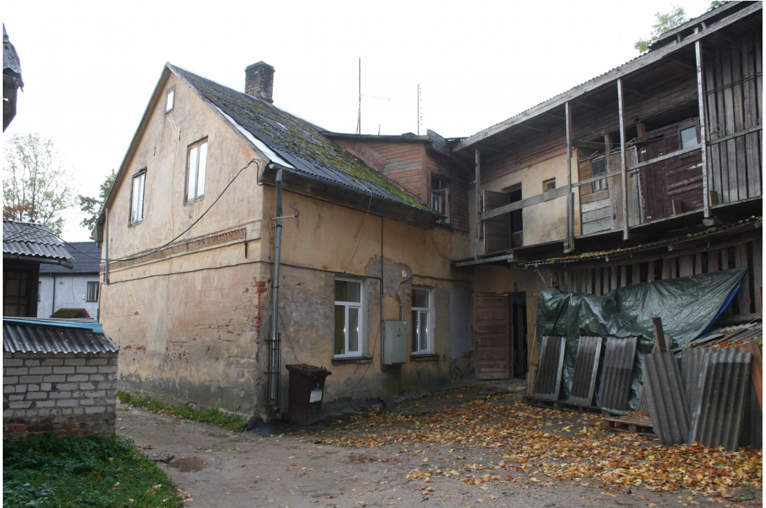
Laidzes_10_88010120216001_fasade4 Skats uz ēku no ziemeļiem.
