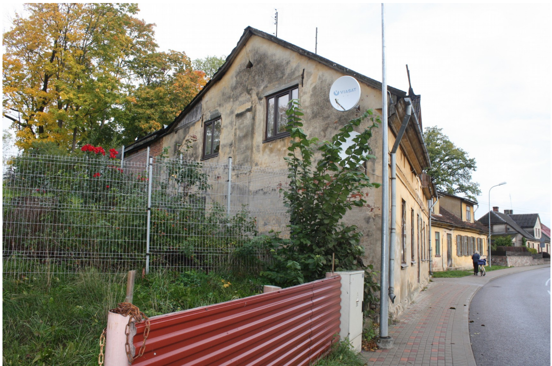
Laidzes_10_88010120216001_fasade5 Skats uz ēku no dienvidrietumiem.
