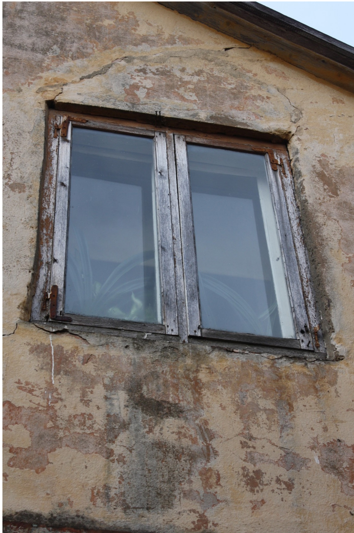
Laidzes_10_88010120216001_logs1 Sākotnēja (19.gs./20.gs.mija) loga aploda un aprīkojums. Vērtnes sekundāras.
