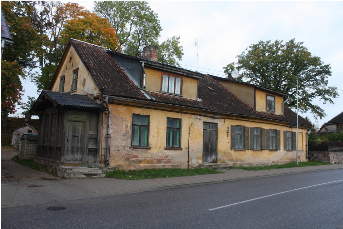
Laidzes_10A_88010120217001_fasade1 Skats uz ēku no dienvidiem. Jumta izbūves izveidotas 20.gs.2.pusē.
