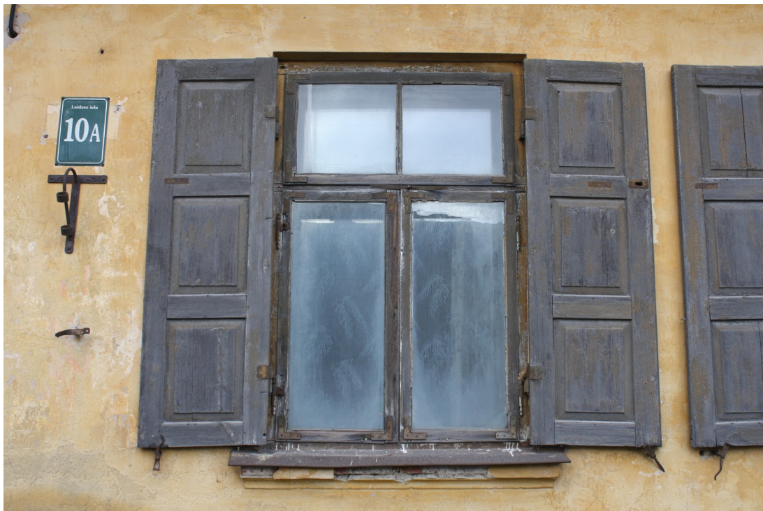
Laidzes_10A_88010120217001_logs2 Sākotnējs (19.gs./20.gs. mija) logs un slēgi ar oriģinālo aprīkojumu.
