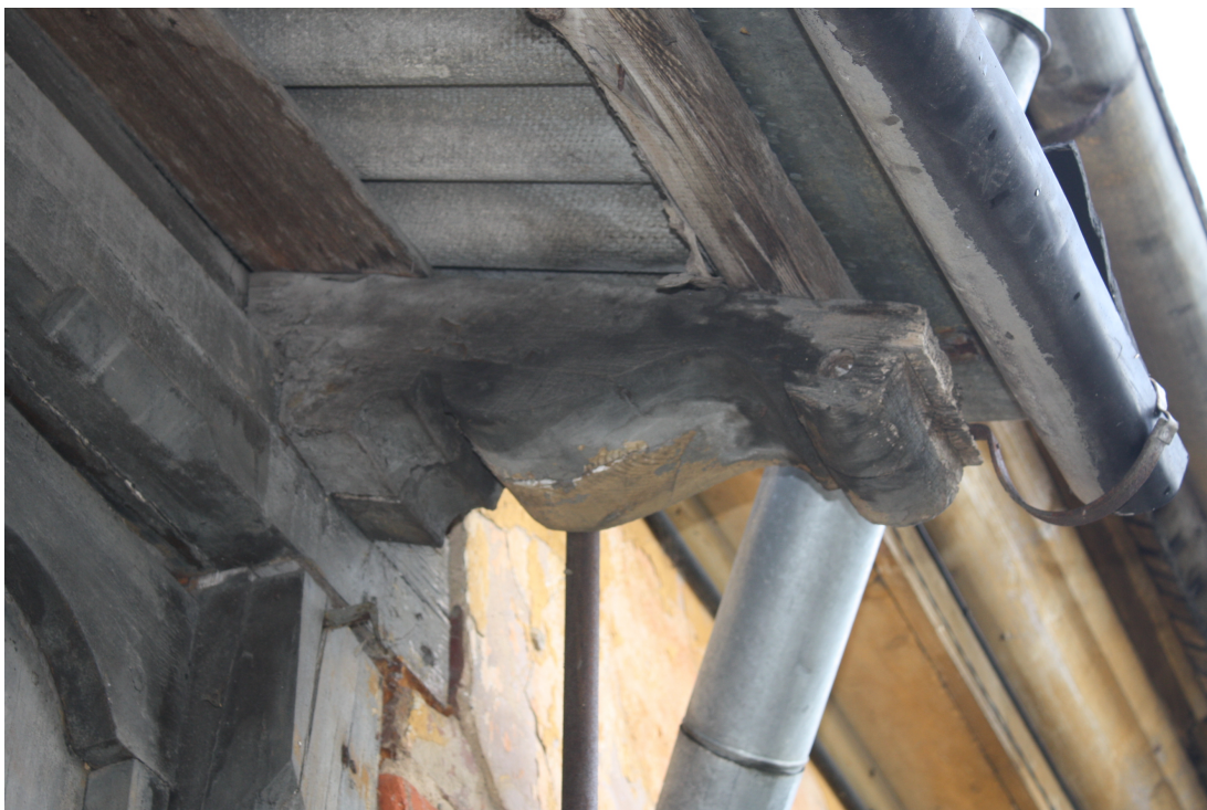
Laidzes_10A_88010120217001_detala1 Sākotnējs (19.gs./20.gs. mija) dekoratīvi griezts spāres gals.
