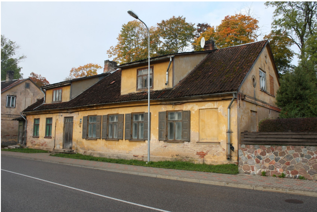
Laidzes_10A_88010120217001_fasade2 Skats uz ēku no austrumiem. Jumta izbūves izveidotas 20.gs.2.pusē.
