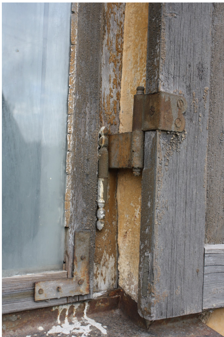
Laidzes_10A_88010120217001_logs3 Sākotnējā (19.gs./20.gs. mija) loga un slēga aprīkojums.
