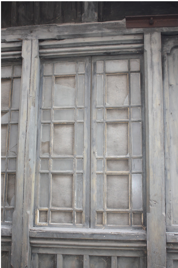
Laidzes_10A_88010120217001_fragments2 Sākotnējās (19.gs./20.gs. mija) verandas oriģinālās apdares fragments.
