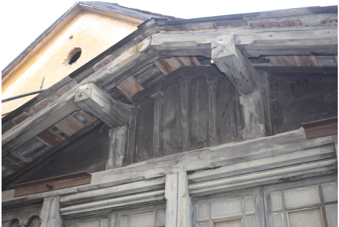
Laidzes_10A_88010120217001_fragments2 Sākotnējās (19.gs./20.gs. mija) verandas oriģinālās apdares fragments.
