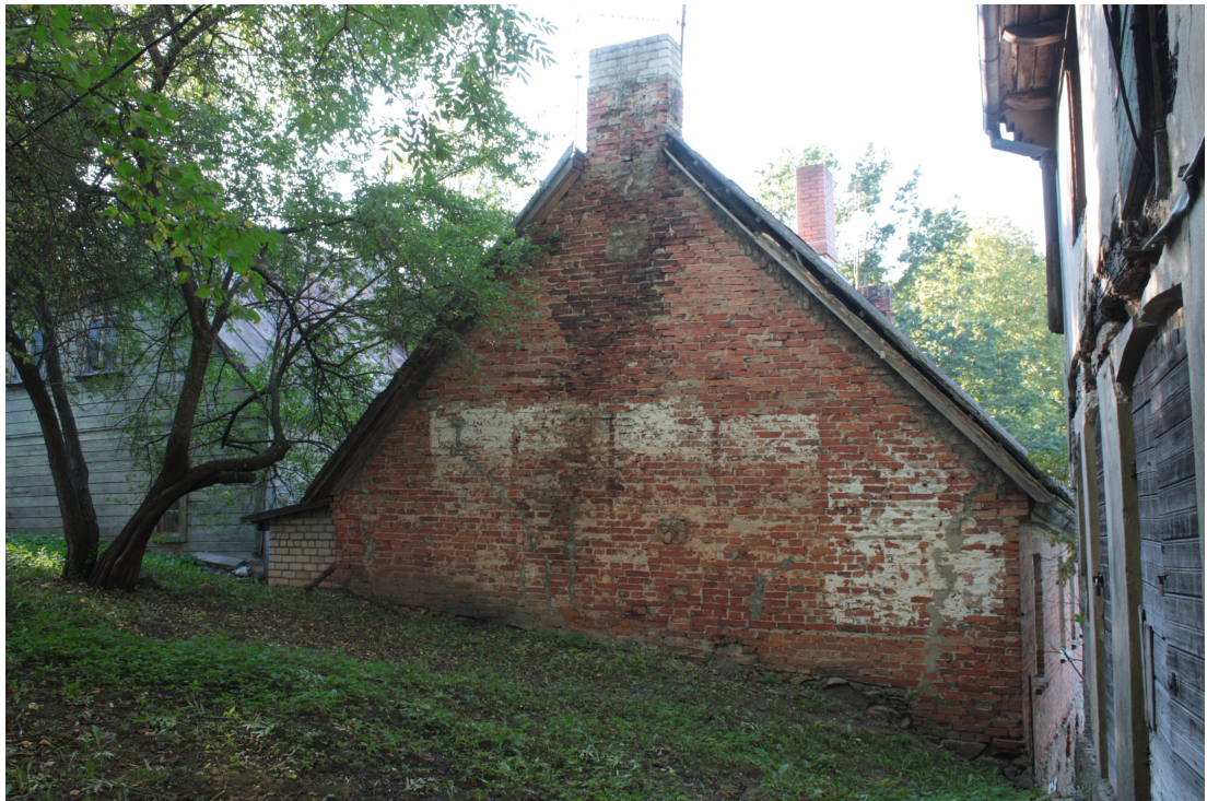
Lielaa_10A_88010090137002_fasade4 Skats uz ēku no dienvidaustrumiem.
