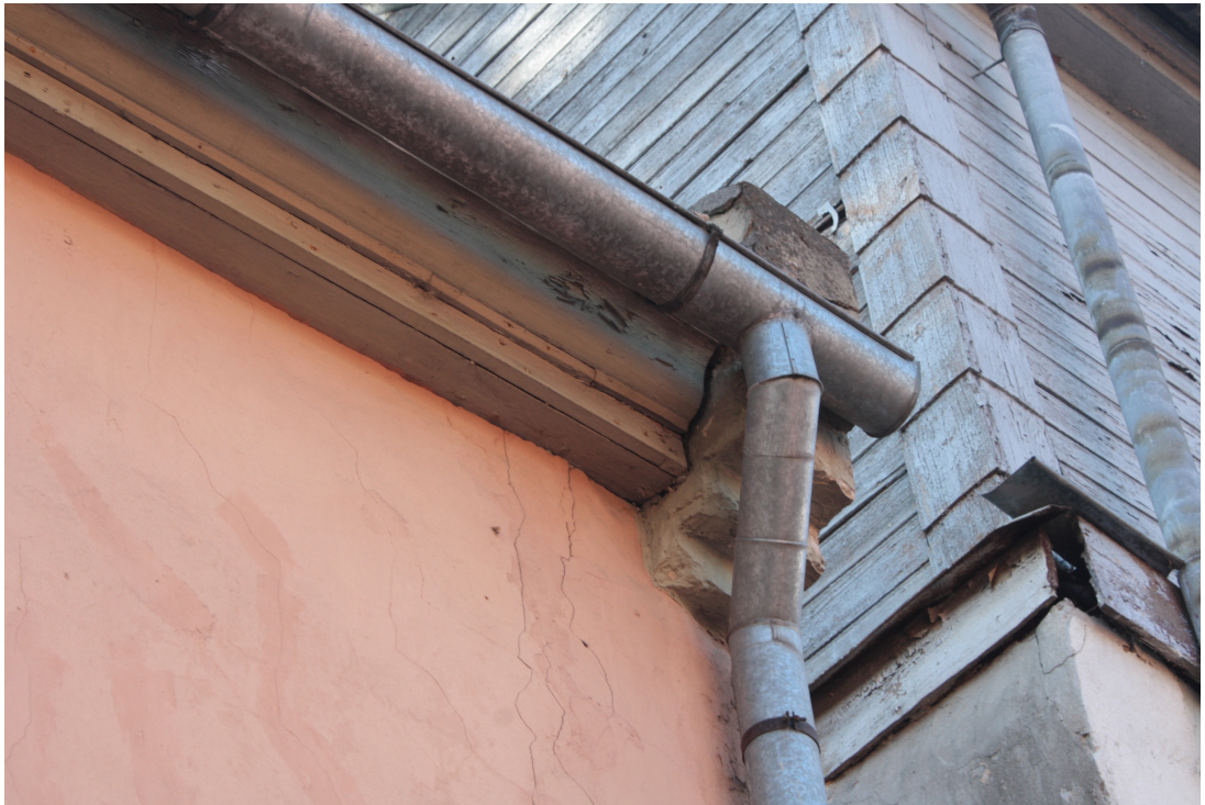
Liela_11_88010090013001_dzega1 Skats uz 20.gs.2.pusē pārbūvētās ēkas daļas stūri ar dēļu dzegu.
