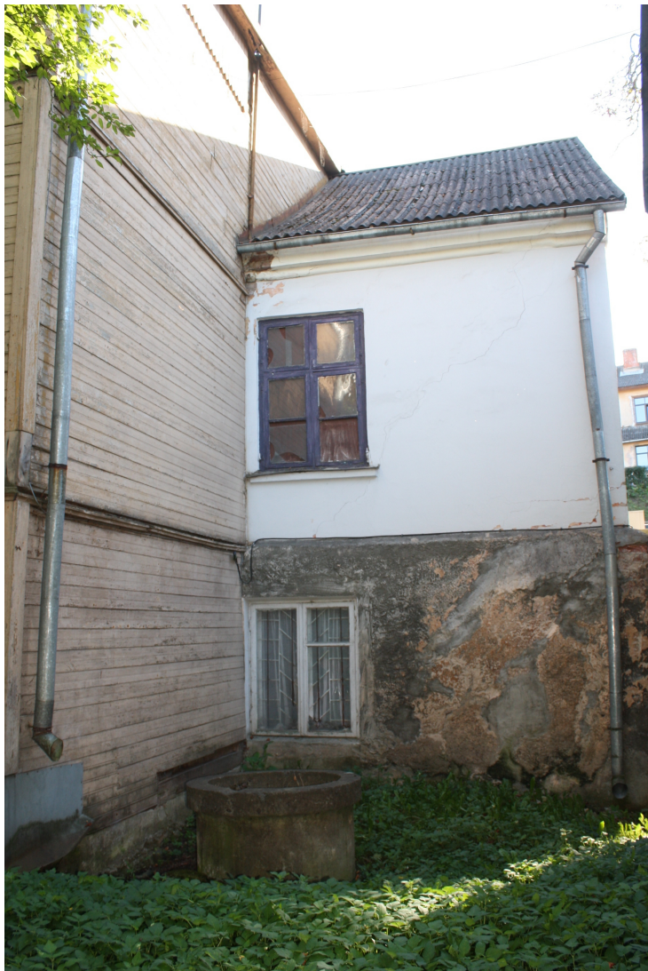
Liela_12_88010090073001_fasade4 Skats uz fasādes daļu no ziemeļiem.
