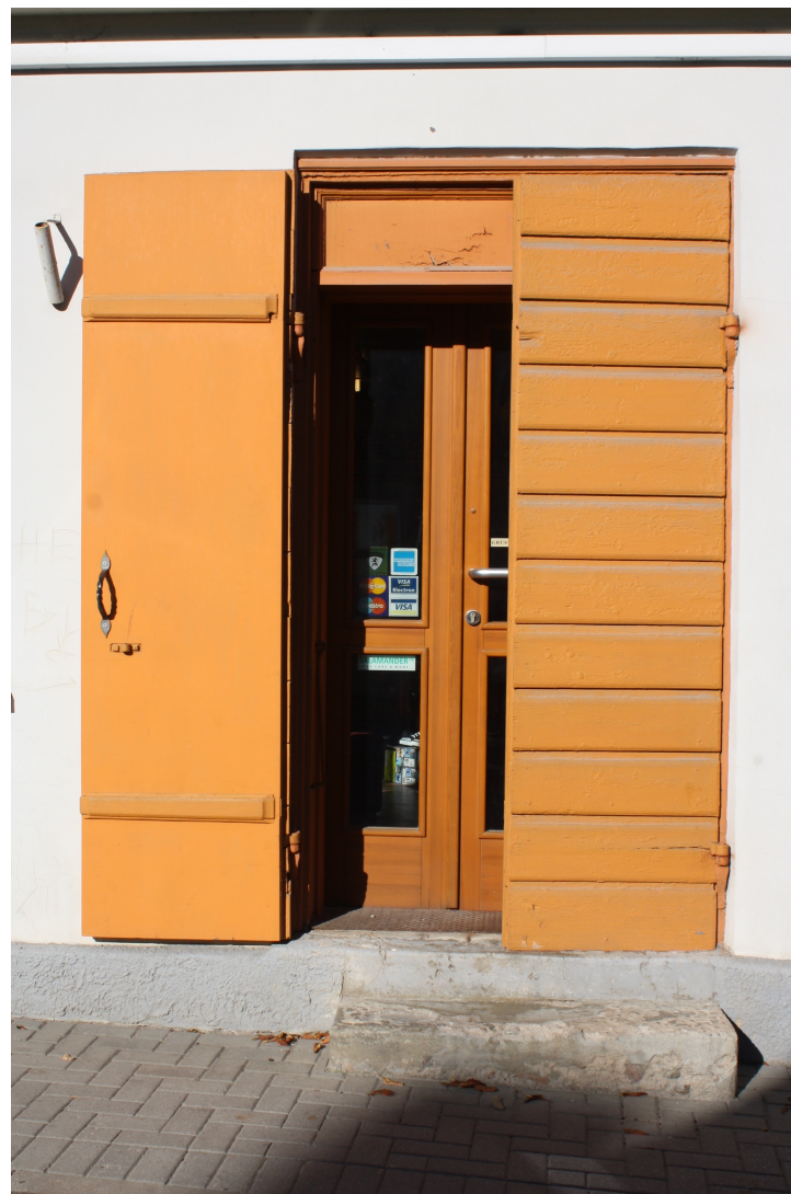
Liela_12_88010090073001_durvis1 Sākotnējie durvju slēgi ar oriģinālo aprīkojumu. Saglabājusies durvju aploda ar virslogu.
