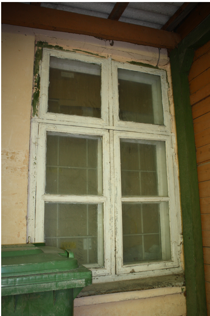
Liela_12_88010090073001_logs1 20.gs.sāk. logs ar aprīkojumu. Slēgi zuduši.
