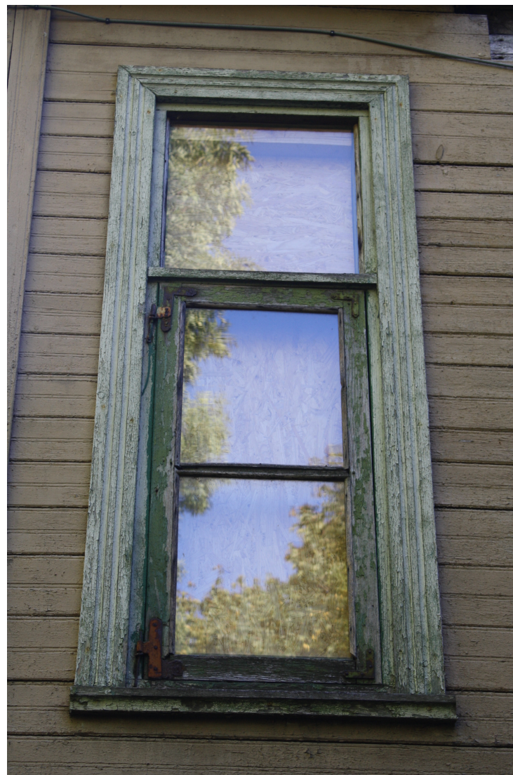
Liela_12_88010090073001_logs4 20.gs.1.cet.logs ar aprīkojumu. Augšējā vērtne zudusi.
