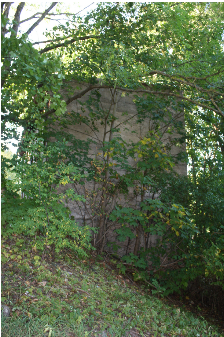
Lielaa_12_88010090073002_fasade3 Skats uz ēku no ziemeļrietumiem.
