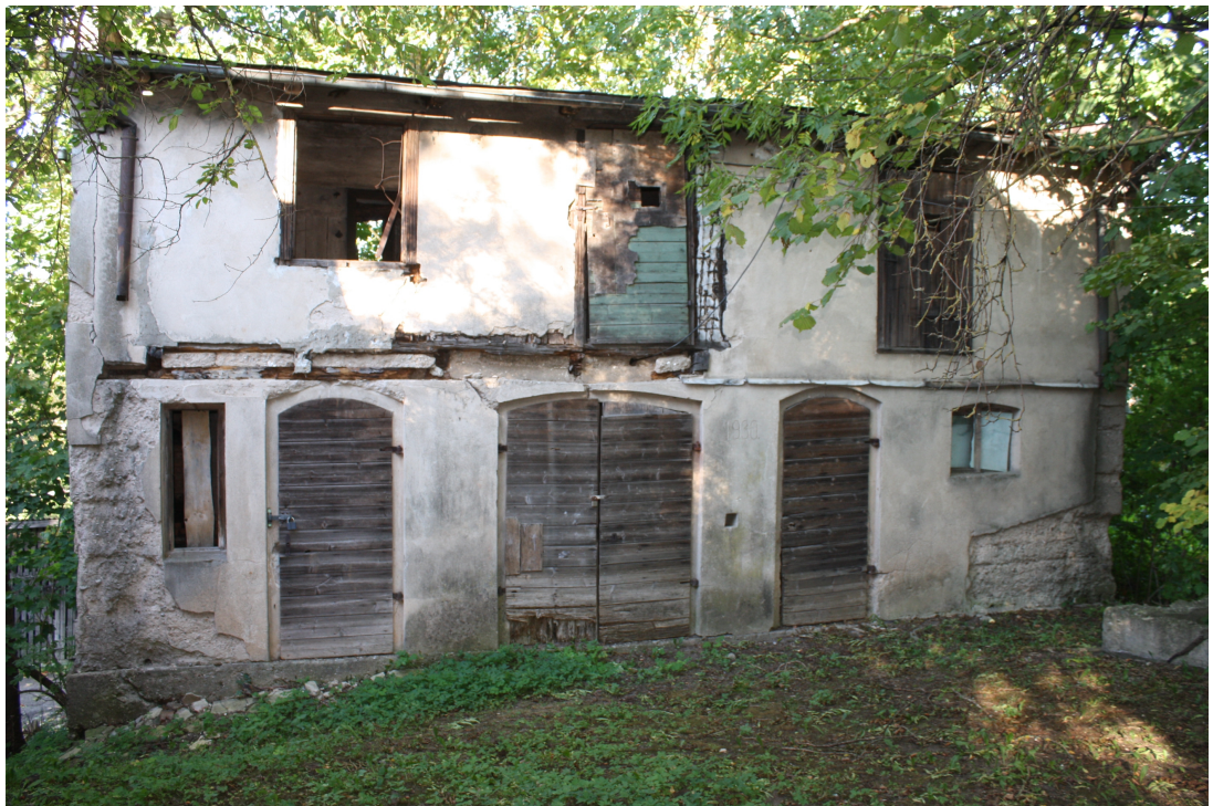
Liela_12_88010090073002_fasade2 Skats uz ēku no dienvidrietumiem. Ēkai zudusi galerija 2.stāva līmenī.
