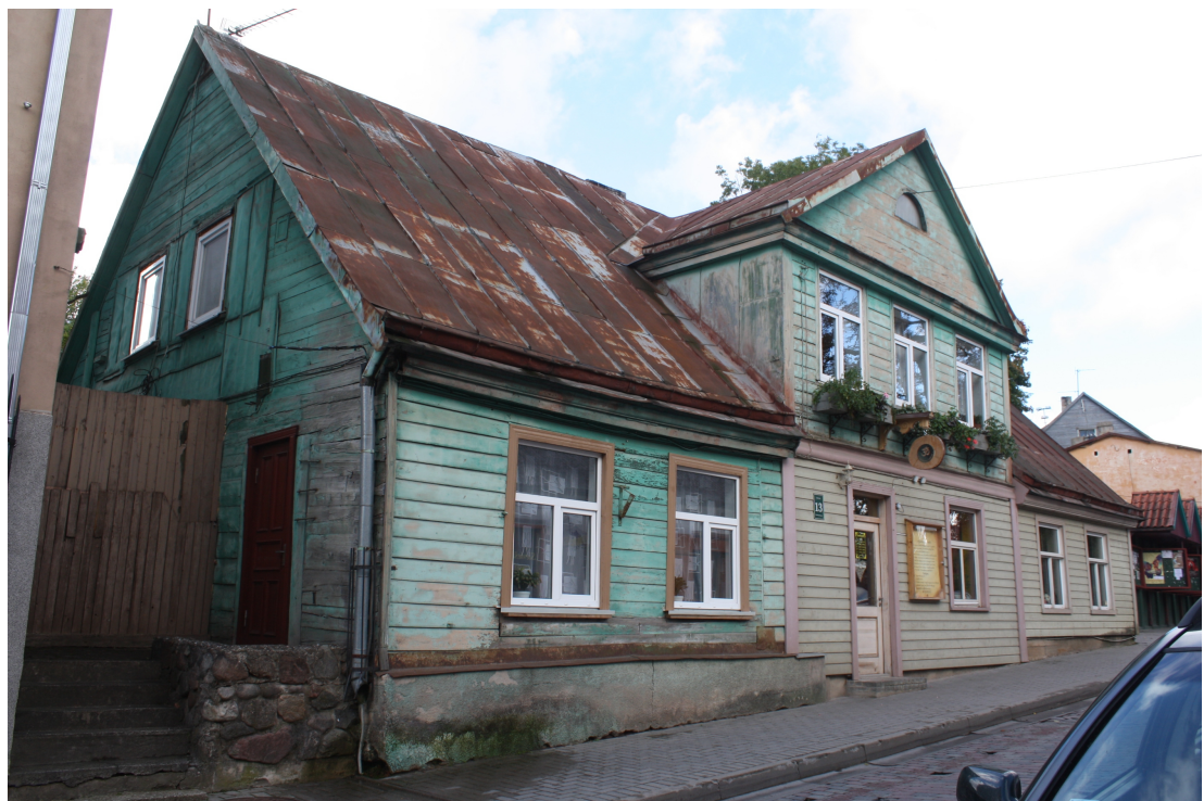
Liela_13_88010090136001_fasade2 Skats uz ēku no ziemeļaustrumiem.
