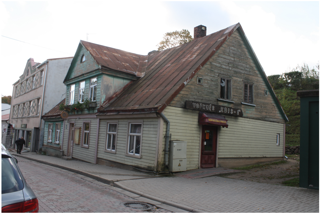
Liela_13_88010090136001_fasade1 Skats uz ēku no ziemeļrietumiem.
