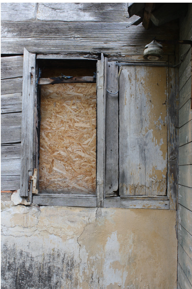
Liela_13_88010090136001_logs1 Sākotnēja loga aploda un kāšu viras. Vērtnes zudušas.
