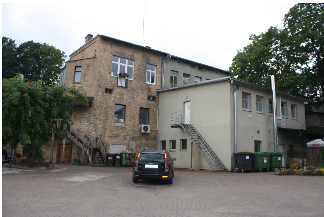
Lielaa_16_88010090024001_fasade4 Skats uz ēku no ziemeļaustrumiem. Apmestā ēkas daļa – 1963.gada piebūve.
