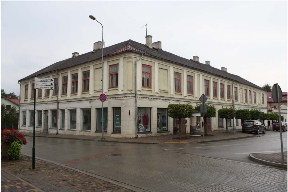
Lielaa_22_88010090050001_fasade1 Skats uz ēku no austrumiem.
