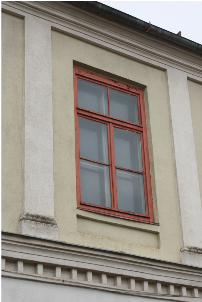
Lielaa_22_88010090050001_fragments2 20.gs.2.puses oderlogs ar sākotnējam logam atbilstošu dalījumu.
