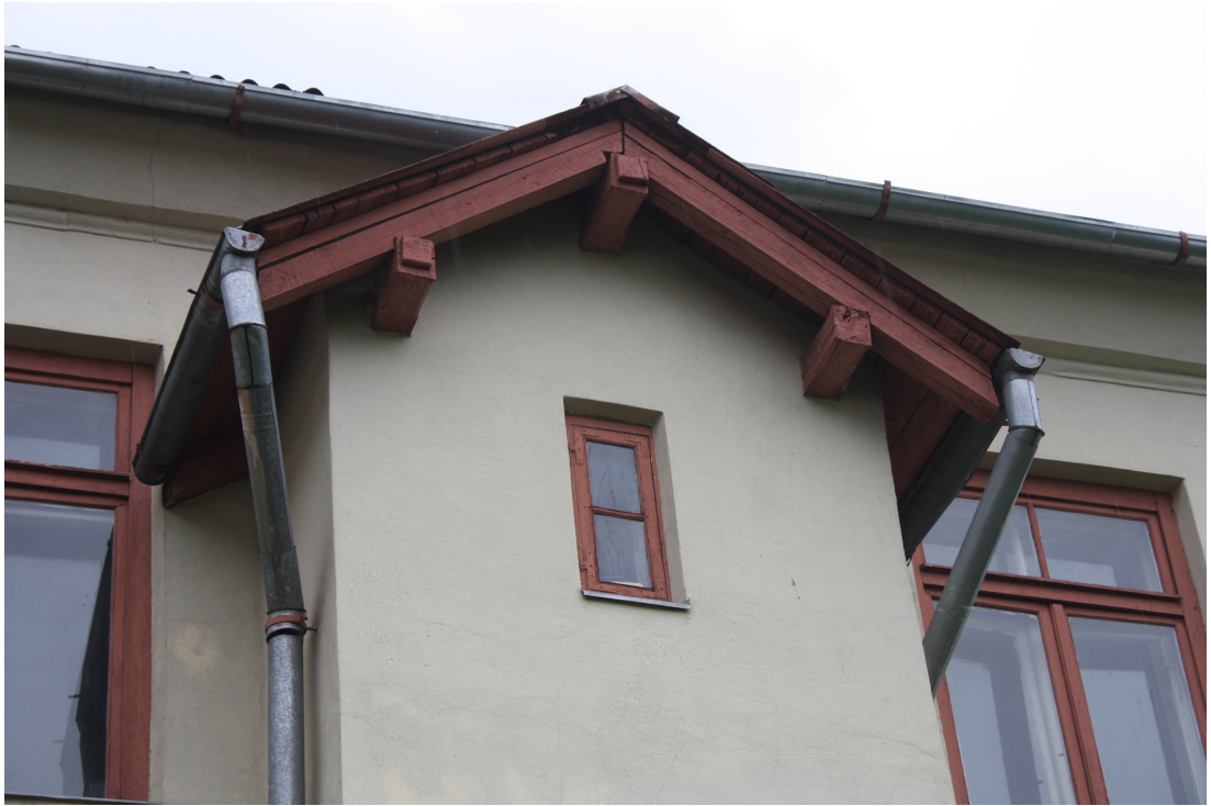
Lielaa_22_88010090050001_fragments4 Skats uz sākotnējās pagalma piebūves augšējo daļu ar oriģinālo logu un kāšu virām.
