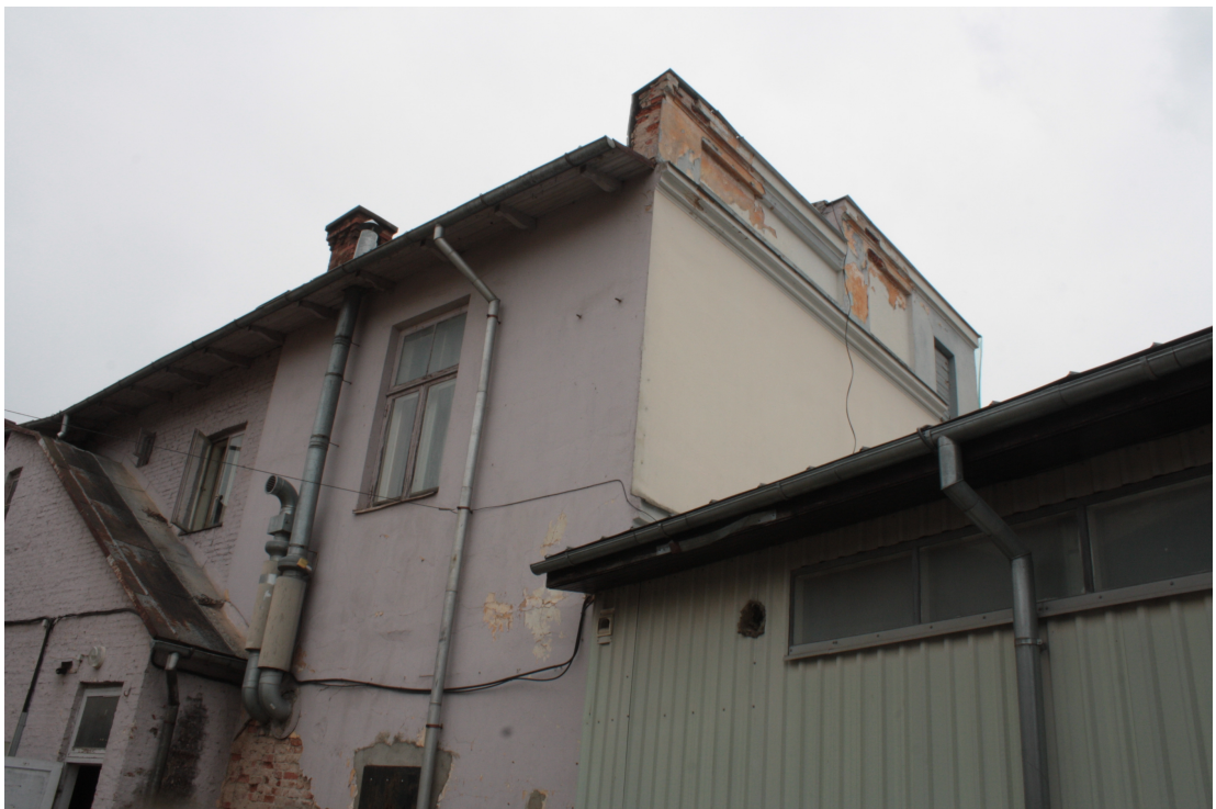
Lielaa_24_2_88010120187001_fragments5 Skats uz 1931.gadā paplašināto ēkas daļu no ziemeļaustrumiem.
