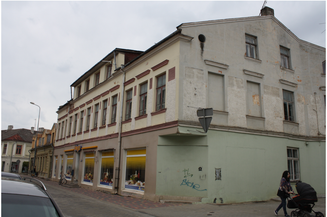
Liela_26_88010120188001_fasade1 Skats uz ēku no dienvidaustrumiem. Slīpais stūris 1.stāvā un jumta izbūve - 20.gs.2.puse.
