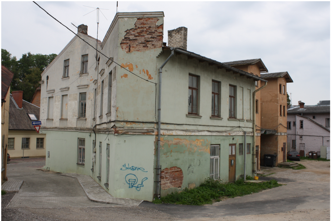
Liela_26_88010120188001_fasade3 Skats uz ēku no ziemeļaustrumiem.
