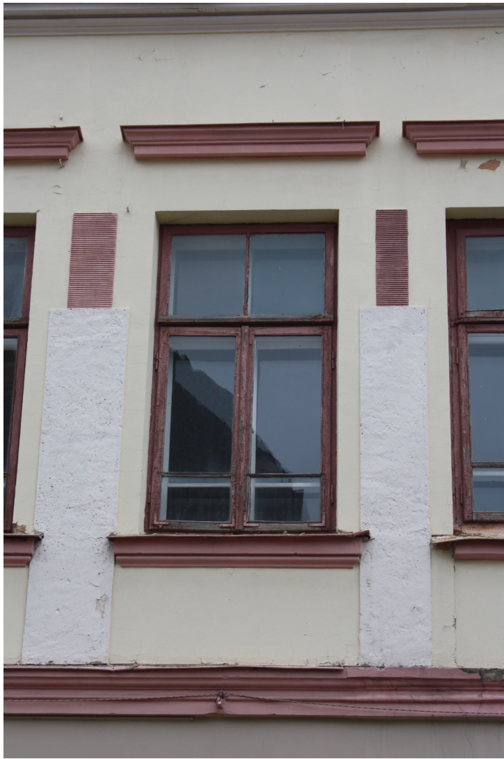
Lielaa_26_88010120188001_ fragments3 Ielas fasādes fragments ar sākotnējo apdari un oriģinālo logu.
