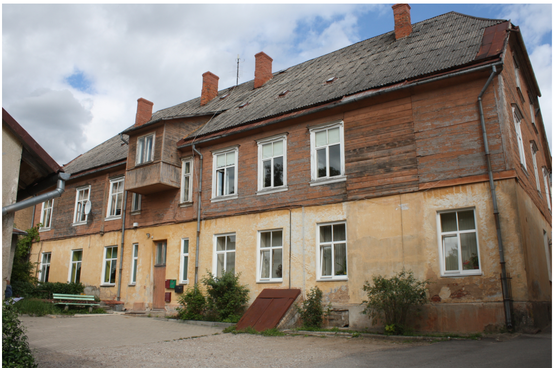
Lielaa_27_88010130140001_fasade5 Skats uz ēku no dienvidiem. 20.gs.2.pusē likvidētas vēsturiskās piebūves, uzcelta jauna izbūve starp jumtu un 2.stāvu
