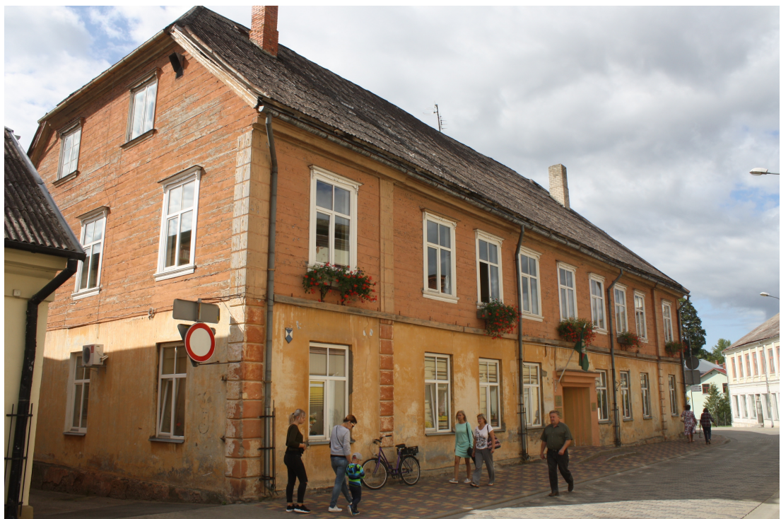
Liela_27_88010130140001_fasade3 Skats uz ēku no ziemeļaustrumiem. Portāls fasādes centrā izveidots 1950.g.
