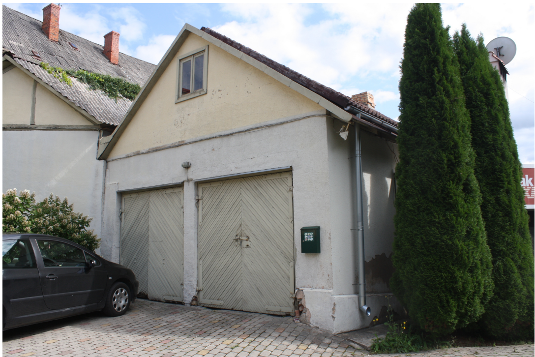
Liela_27_88010130140004_fasade2 Skats uz ēkas rietumu fasādi. Vārtu ailas izbūvētas 20.gs.2.pusē.
