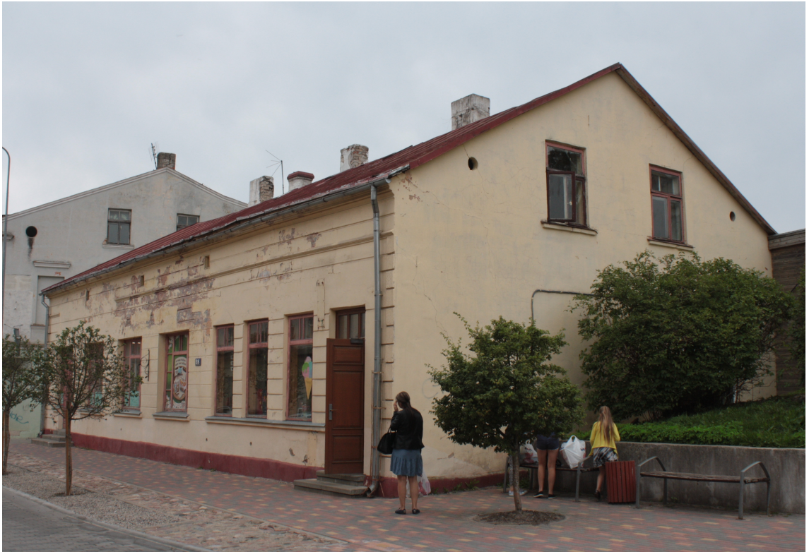
Liela_28_88010120189001_fasade1 Skats uz ēku no dienvidaustrumiem.
