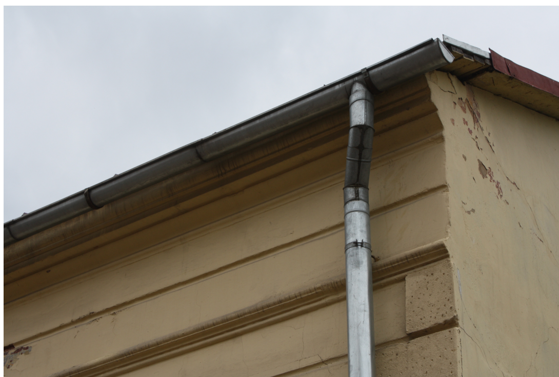
Lielaa_28_88010120189001_detala1 Sākotnējā dzega.
