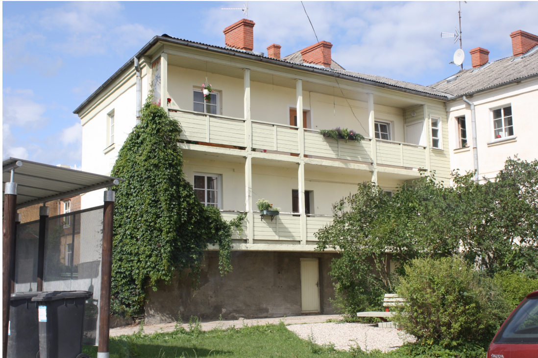
Lielaa_29_88010130141001_fasade4 Skats uz pagalma piebūvi no dienvidaustrumiem. 19.gs. beigu piebūve pārbūvēta 1980.gados.
