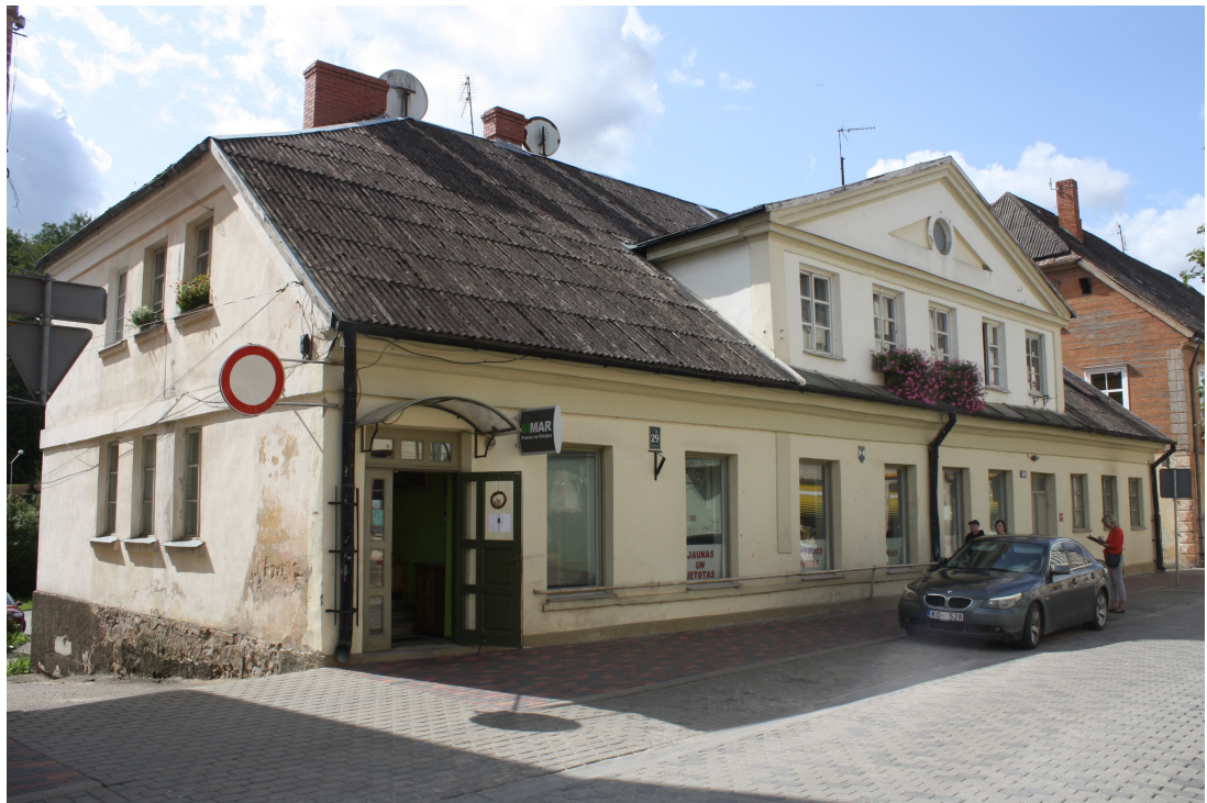
Liela_29_88010130141001_fasade2 Skats uz ēku no ziemeļaustrumiem.
