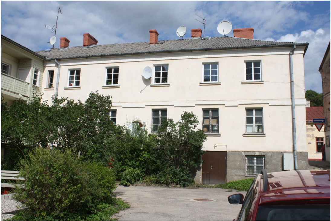
Lielaa_29_88010130141001_fasade3 Skats uz ēkas dienvidu fasādi ( piebūvēta 1953.g.)
