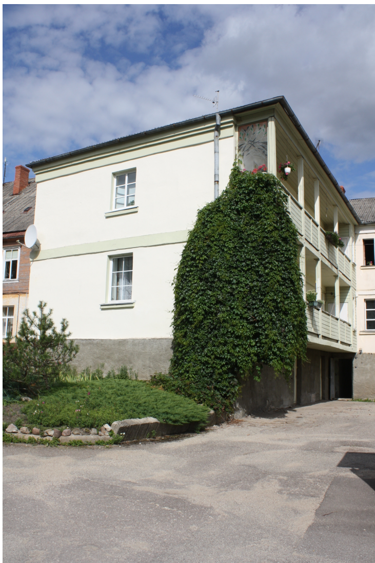
Lielaa_29_88010130141001_fasade5 Skats uz piebūves dienvidu fasādi.
