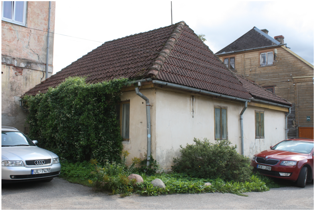
Lielaa_29a_88010130141004_fasade1 Skats uz ēku no ziemeļrietumiem.
