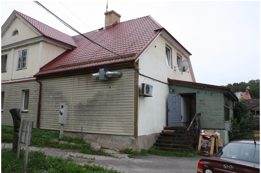
Lielaa_30_88010120190001_fasade5 Skats uz ēkas R pusi no ziemeļrietumiem. Mainīts fasāžu ailojums. Koka piebūve – 20.gs.2.puse.
