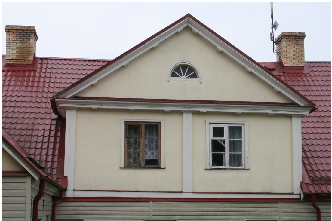
Lielaa_30_88010120190001_fragments1 Skats uz mezonīnu ēkas ziemeļu fasādē. Saglabājusies sākotnējā koka detaļu apdare, ieskaitot, frontona logailu.
