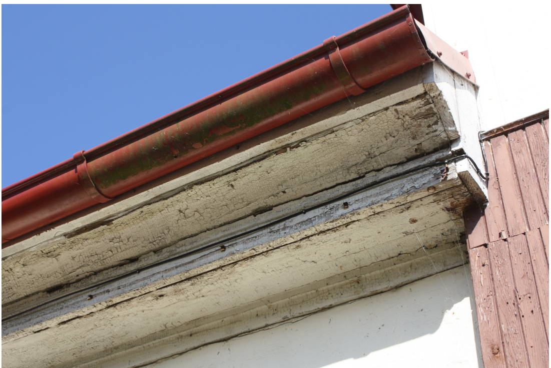
Lielaa_30_88010120190001_dzega1 Sākotnējās (labotas) dēļu dzegas fragments.
