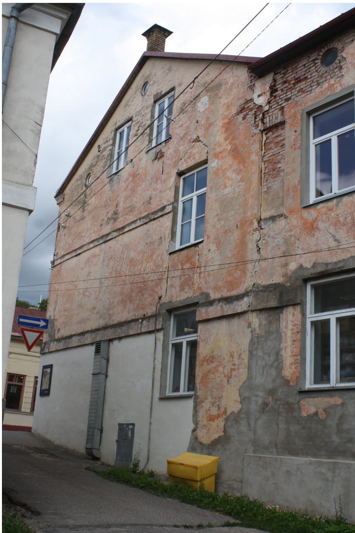
Lielaa_31_88010130019001_fasade7 Skats uz ēkas rietumu fasādi no dienvidrietumiem.
