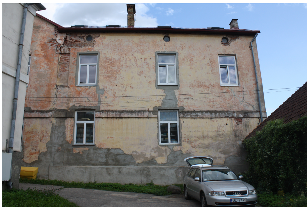
Lielaa_31_88010130019001_fasade6 Skats uz ēkas pagalma korpusa rietumu fasādi. Iespējams, sienā daļēji, saglabātas 19.gs.4.cet. konstrukcijas (?).
