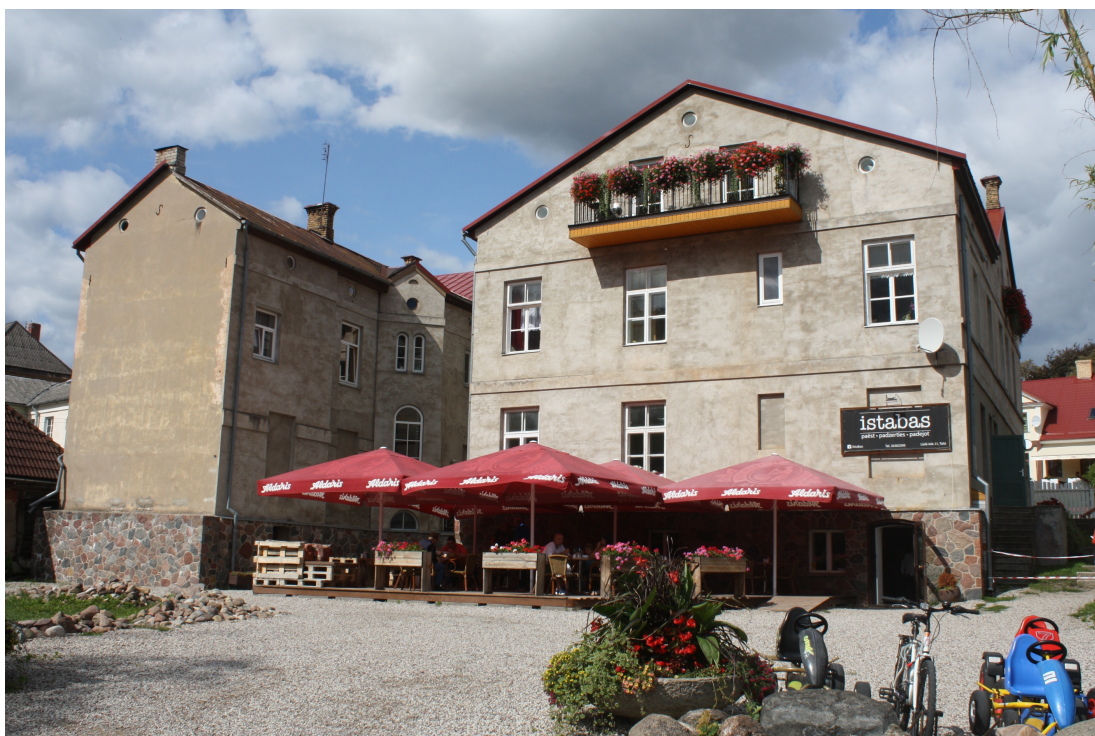
Lielaa_31_88010130019001_fasade5 Skats uz ēku no dienvidaustrumiem.
