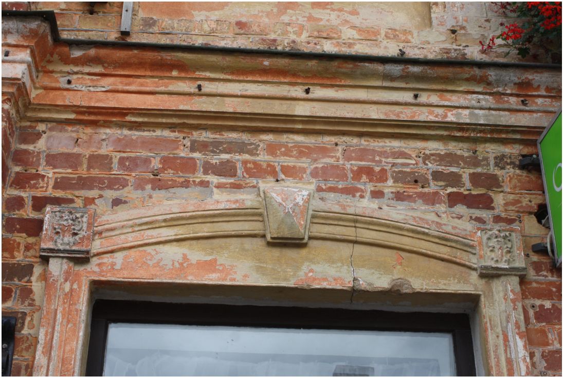
Liela_31_88010130019001_detala1 Sākotnēja cementa lējuma logailas apdare.
